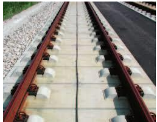
Рисунок 1.1 – Візуальне порівняння баластної та безбаластної колії [2]
