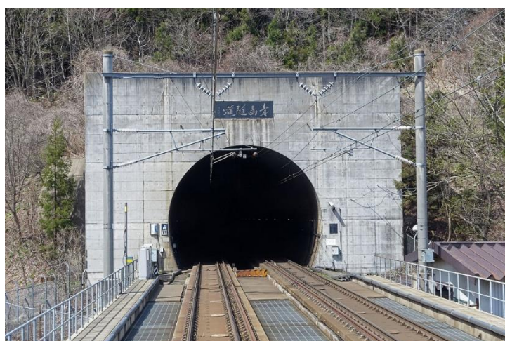
Рис. 3.5. Вхід в тунель з боку Хонсю, двоколійна ділянка [108]
