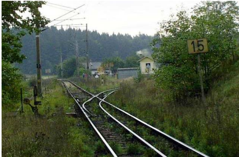
Рис. 2.12. Трирейкова колія поблизу станції Їндржихув – Градец в Чехії Джерело: https://w.wiki/_pQAC
