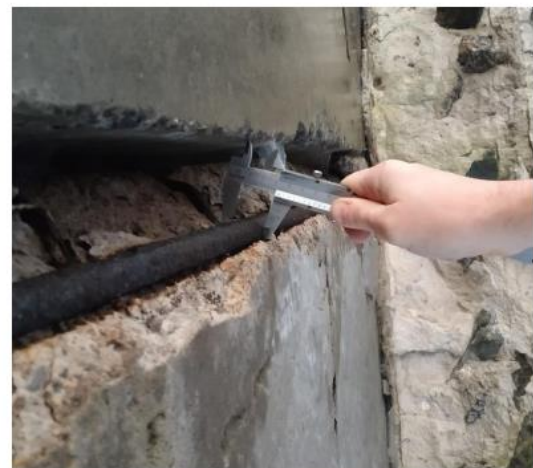
Фото И.32/33 – Систематичне замокання плит, оголення і корозія арматурних стержнів з виколами бетону і виключенням з роботи окремих стрижнів нижнього армування
