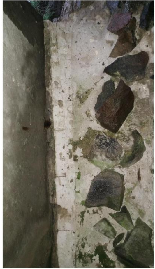
Фото И.29 – Вимивання розчину бутового мурування опорних конструкцій моста
