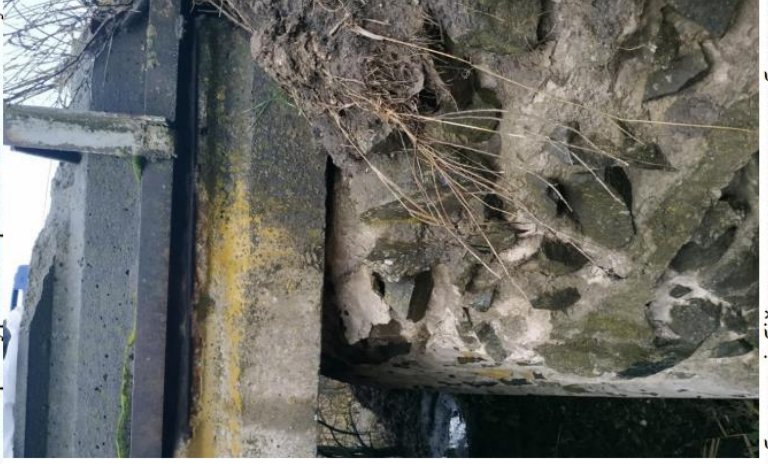
Фото И.7 – Виколи бетону відбійних плит та окремих бугових каменів опорних конструкцій, вимивання розчину вузлів обпірання залізобетонних плит на опорні конструкцій моста
