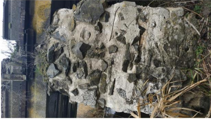
Фото И.11/12 – Розриви сполучних елементів відбійних плит в місцях їх з'єднання, виколи бетону відбійних плит та окремих буттових каменів опорних конструкцій, заростання і забруднення опорних конструкцій моста
