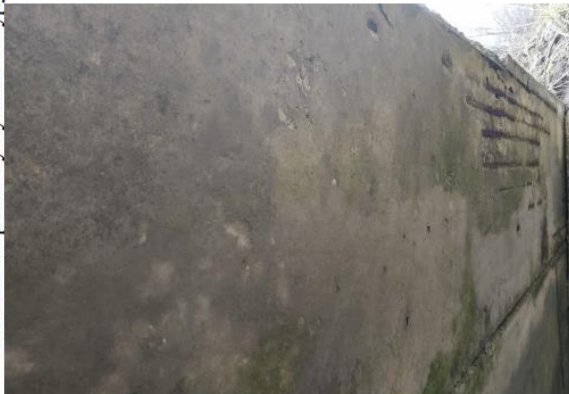
Фото И.16 – Виколи окремих бутових каменів опорних конструкцій моста, вимивання розчину бутового мурування опорних конструкцій моста
