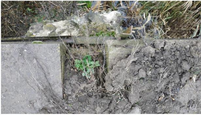
Фото И.11/12 – Розриви сполучних елементів відбійних плит в місцях їх з'єднання, виколи бетону відбійних плит та окремих буттових каменів опорних конструкцій, заростання і забруднення опорних конструкцій моста
