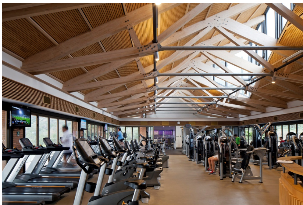
Рис. 2.3.2. – Вигляд оригінальної змонтованої ферми в існуючій будівлі в місті Лас Кондес, Чилі (фото №1)
