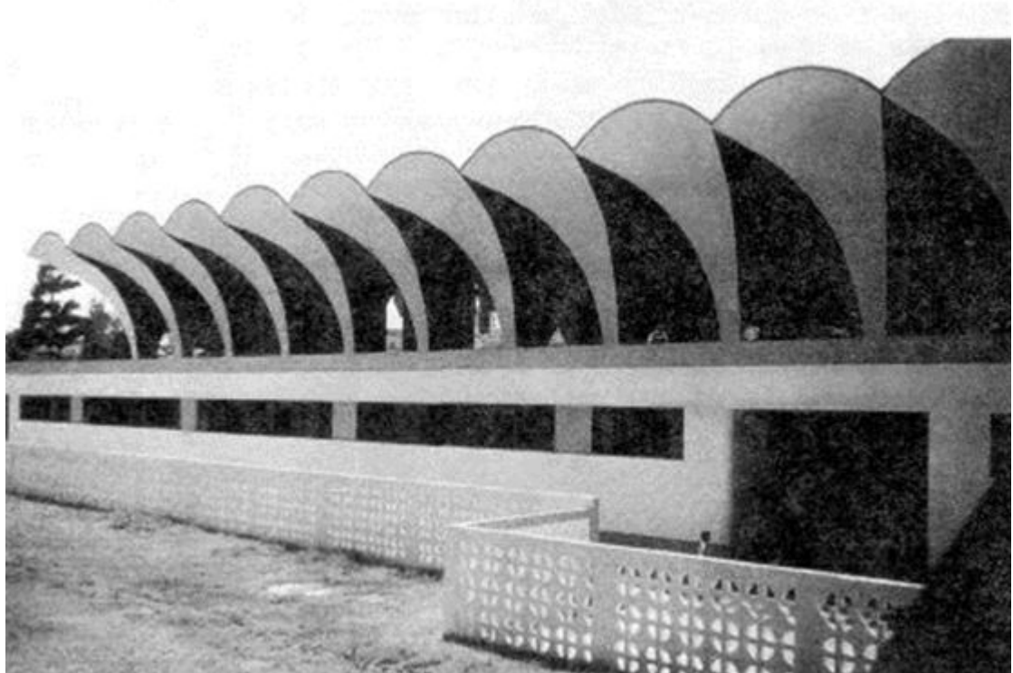
Рис. 1.3.1.2. – Спортивний зал зі зведеною конструкцією покрівлі комплексу Хосе Морті в м. Гавана, Куба
