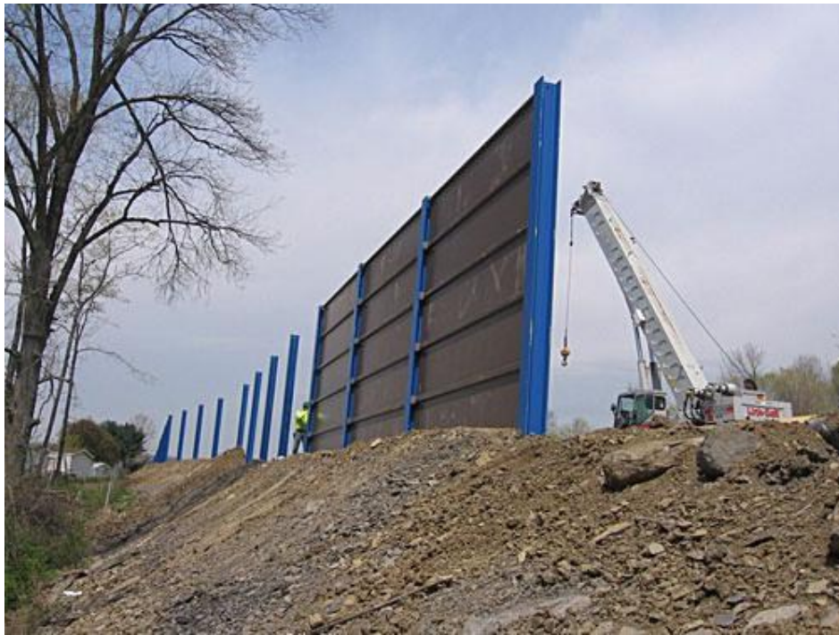
Рисунок 4.1 – Монтаж акустичних екранів
