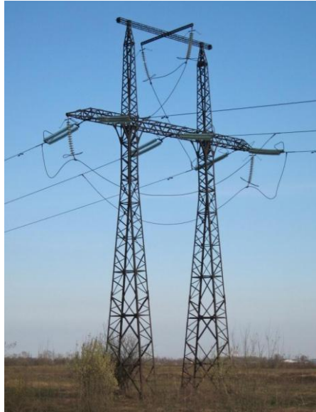
Рисунок 1.7 – Транспозиційна опора
