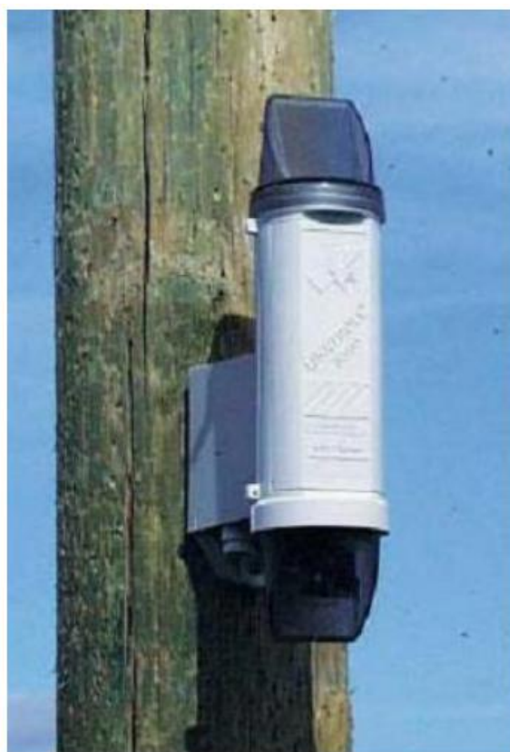
Рисунок 2.4 – Встановлення індикаторів пошкоджень на опорі ПЛ
