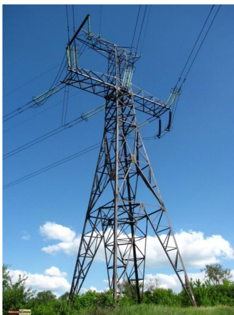
Рисунок 1.5 – Анкерно-кутова одноланцюгова опора
