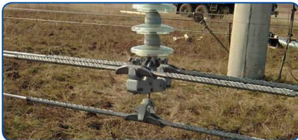
Рисунок 1.2 – Загальний вигляд підтримуючого затискача
