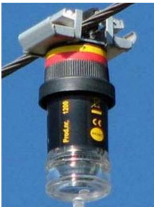
Рисунок 2.3 – Встановлення індикаторів пошкоджень на проводі ПЛ
