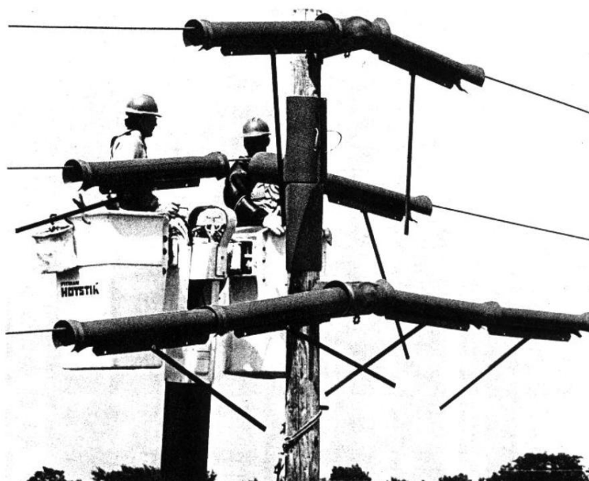
Рисунок 2.1 — Обслуговування повітряної лінії за методом «гумових рукавиць»
