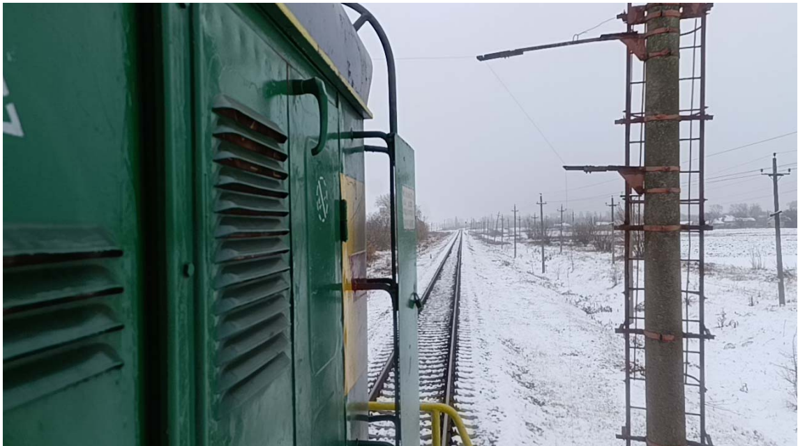
Рисунок 3.2 – Контрольний дріт контрольно - габаритного пристрою на перегоні Перещепине – Бузівка регіональної філії «Придніпровська залізниця» АТ «Укрзалізниця»
