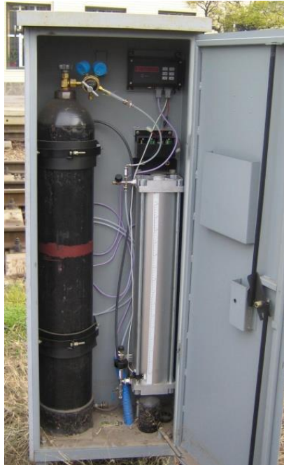
Рисунок 1.3 – Шафа стаціонарного рейкозмащувача СПР-02
