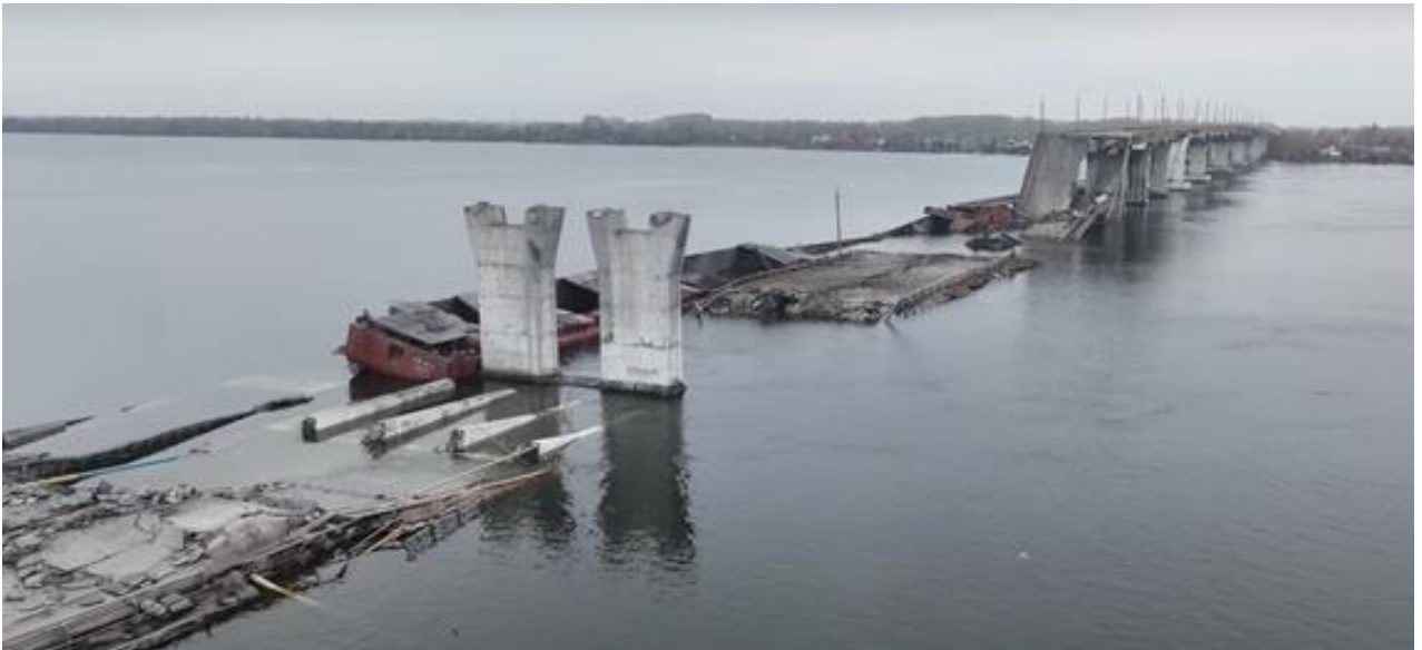
Рисунок 1.4. Зруйновані руслові прогони мостів широких водних перешкод а – через р. Десна, б – через р. Дніпро (із засобів масової інформації, 2022)
