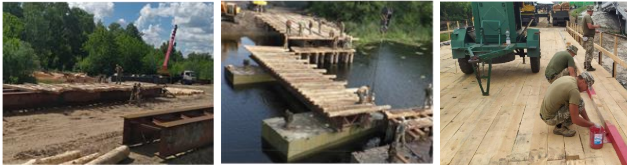
Рисунок 2.4. Етапи спорудження прогонових будов
