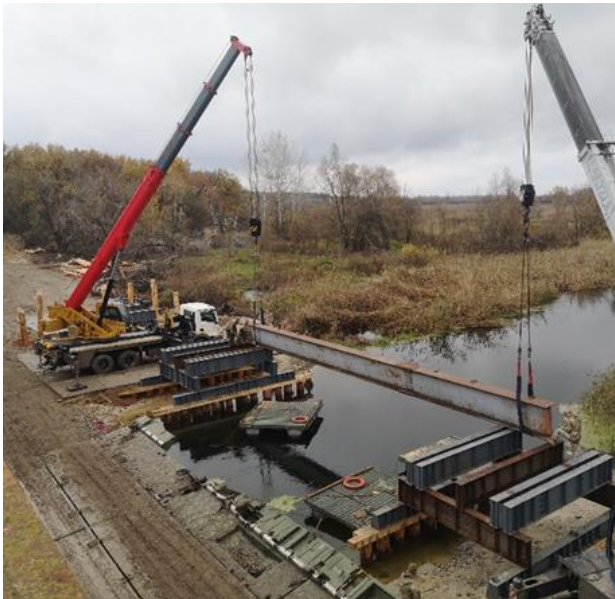
Рисунок 2.8. Встановлення балок прогонових будов в прогін. (із звіту, жовтень 2022)
