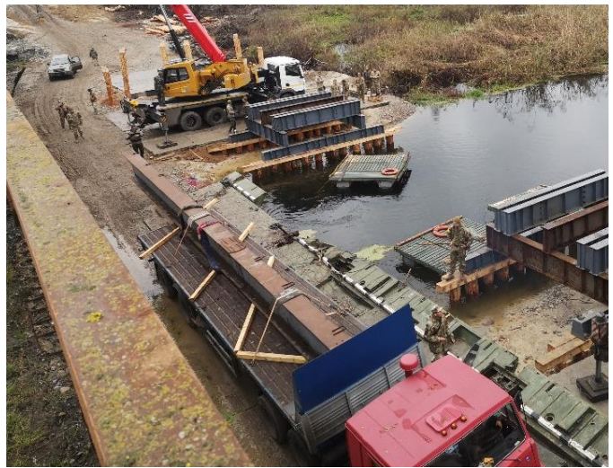
Рисунок 2.7. Підготовка балки для встановлення в прогін (із звіту, жовтень 2022)
