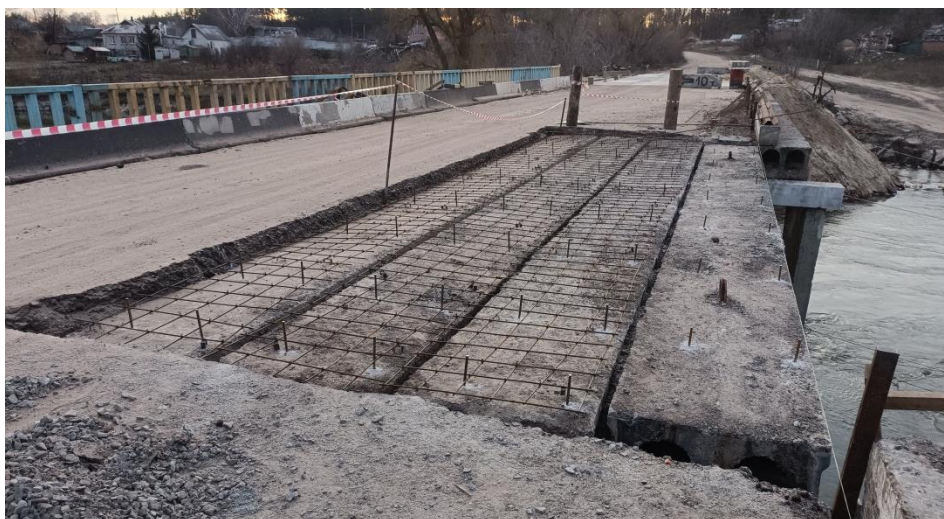
Рисунок 1.8. Використання раніше вживаних залізобетонних балок (із звіту, 2022)
