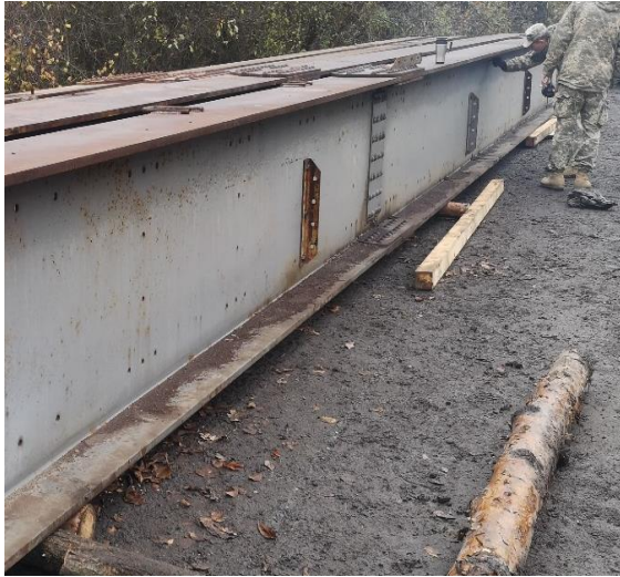
Рисунок 2.7. Підготовка балки для встановлення в прогін (із звіту, жовтень 2022)
