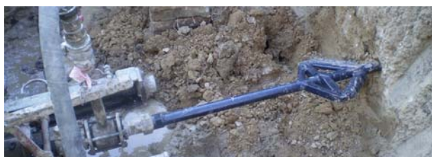
Рис. 1. Трилопатевий бурозмішувач
