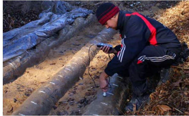
Рис. 3. Вимірювання твердості ґрунтоцементу приладом «Онікс-2,5»
