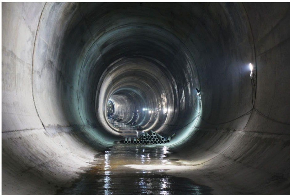
Рис. 4.22. Оправа перегінного тунелю метрополітену ( https://surl.li/ovsxzd )
