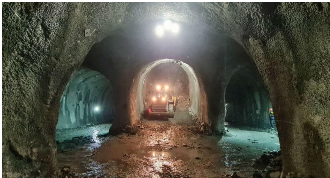
Рис. 1.12. Виробка тримається на тимчасовому кріпленні, гірничий спосіб спорудження тунелів ( https://surl.it/ejshon )
