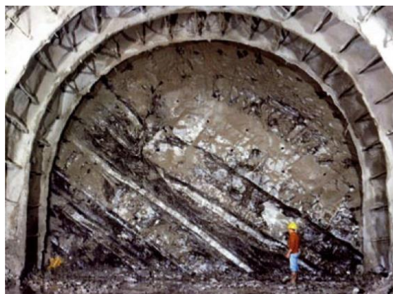
Рис. 2.14. Вид забою при проходці гірських масивів ( https://surl.li/ltjhcp )
