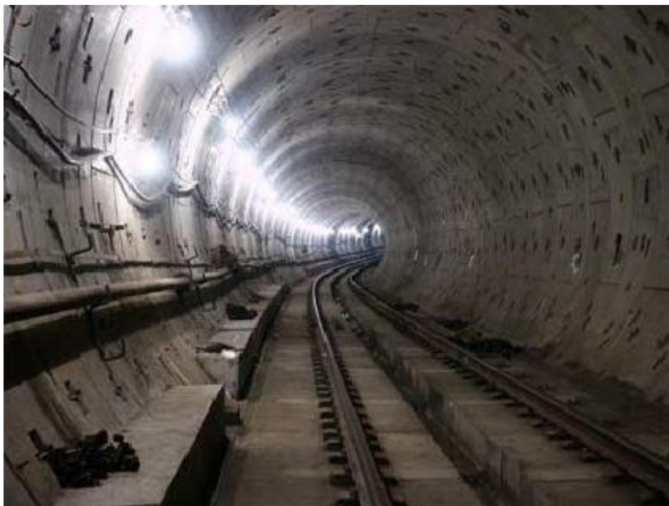
Рис. 4.18. Оправа перегінного тунелю метрополітену із залізобетонних блоків ( https://ssurl.lt/jellyxy )
