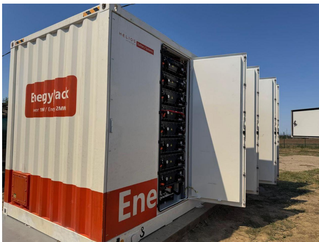
Рисунок 3.2 – Контейнерного рішення, потужність 1 МВт та ємності 2 МВт·год
