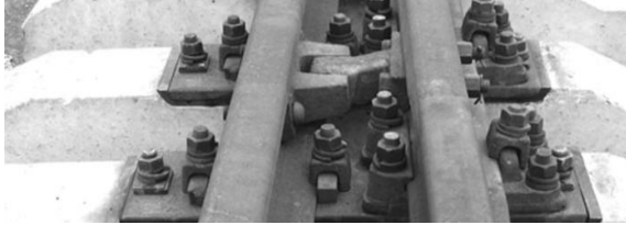
Рис. 3 – Корневое крепление гибкого остряка
