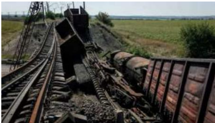
Рисунок 1.4 – Зруйнована ділянка залізниці
