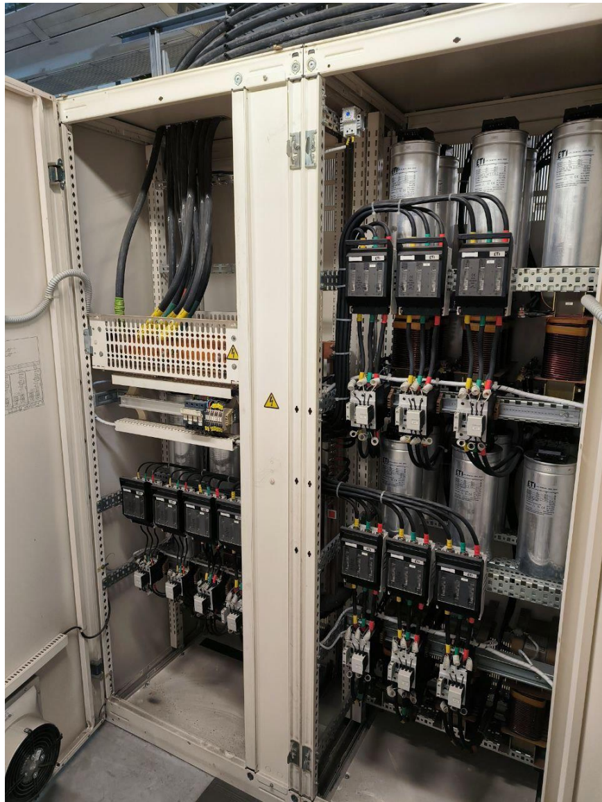
Рисунок 2.2 - Комплектна компенсаційна установка
