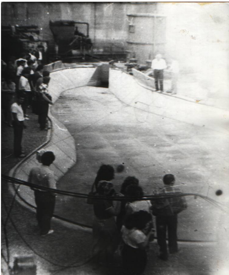
Рисунок 4.2- Модель басейну АЕС (база ВНИИГа ім. Веденєєва Б.Е., м. Дніпродзержинськ).
