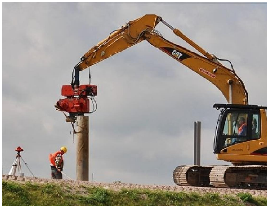
Рис.1.4 Приклад способу занурення палей вібровдавлюванням
