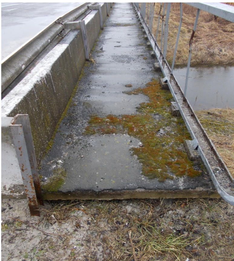
Рисунок 4. Мостове полотно. (Правий тротуар) - Руїнування перильної огорожі
