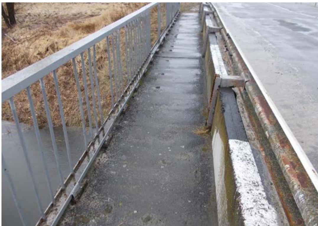
Рисунок 5. Мостове полотно. (Лівий тротуар) - Руїнування перильної огорожі
