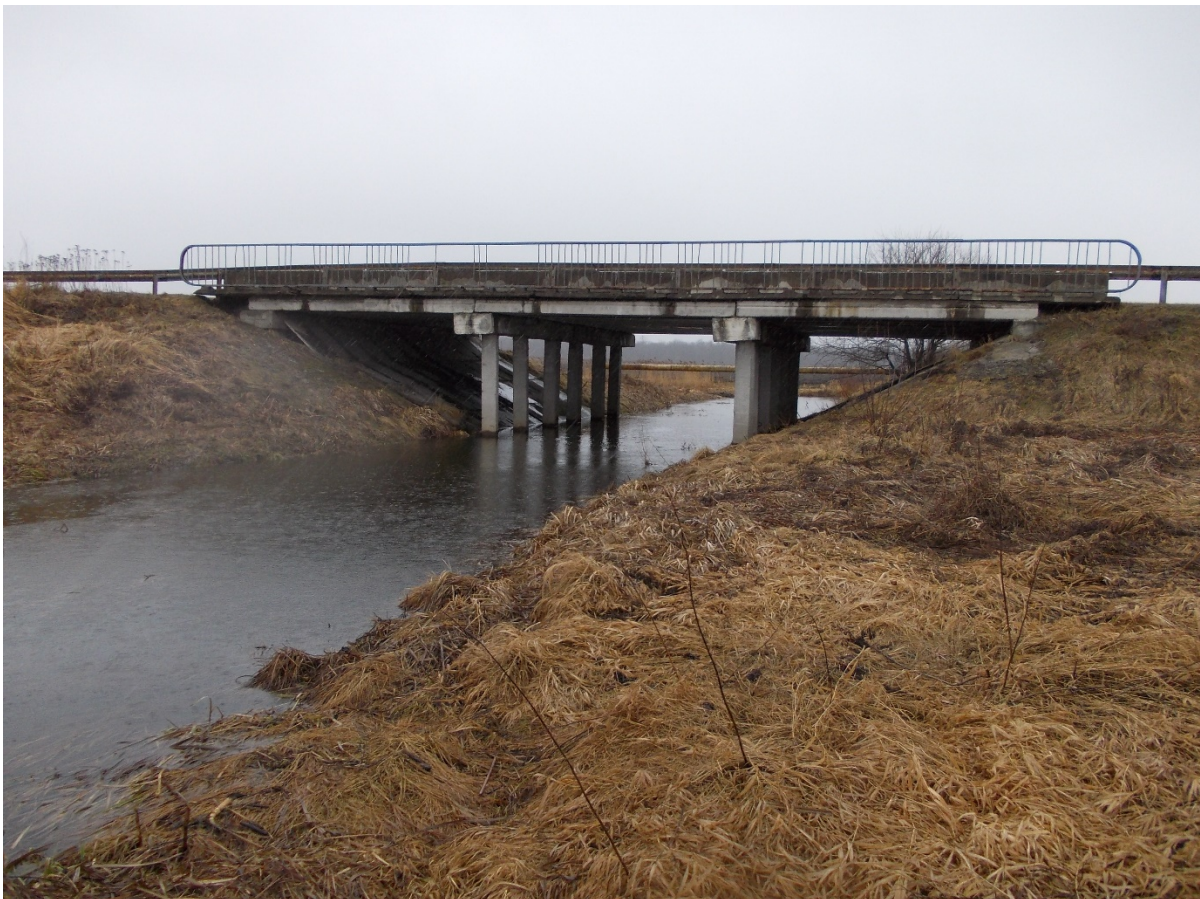
Рисунок 1– Загальний вигляд мосту
