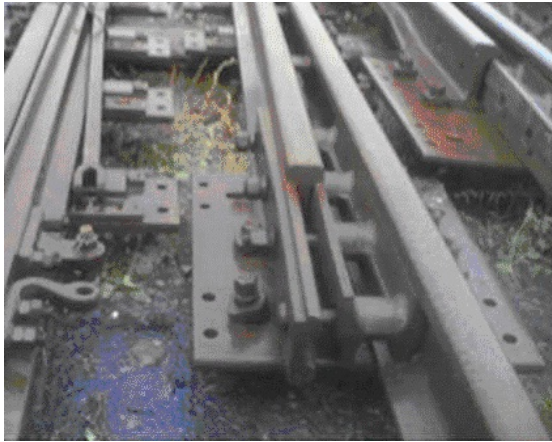
Рис. 6. Кореневе скріплення вкладишно-накладочного типу у розібраному стикі
