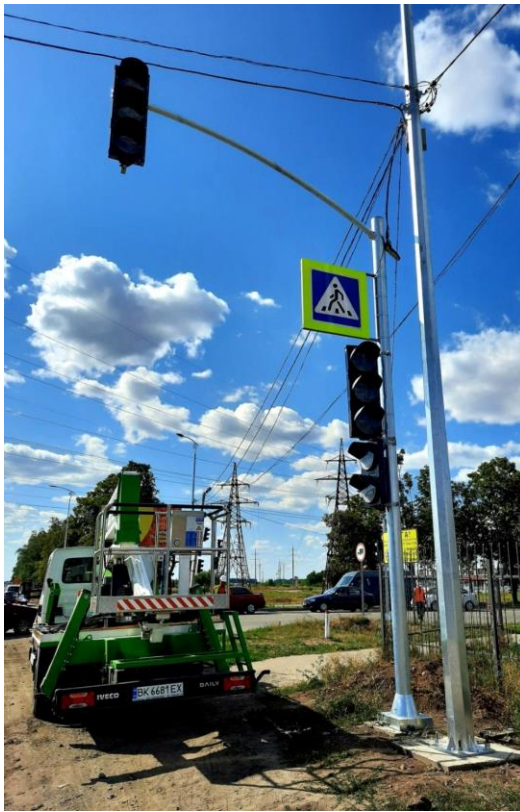
Рисунок 3.5 – Сучасні світлофори Т1.3 та П1.2 з вбудованим циферблатом на опорі з консоллю
