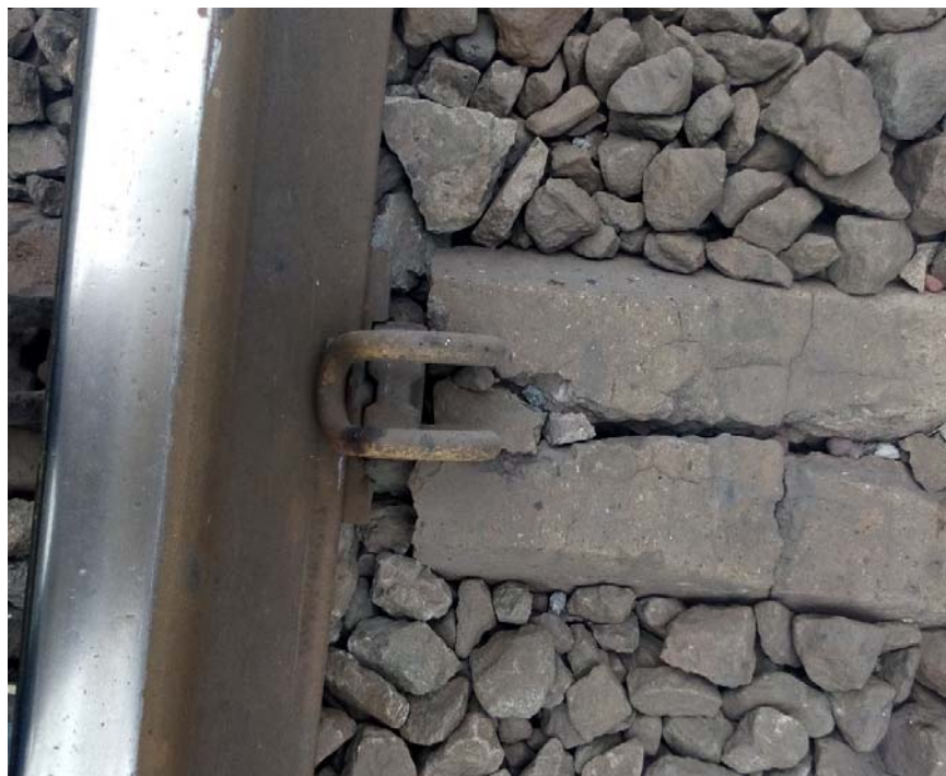
Рисунок. 2 – Непридатна з/б шпала
