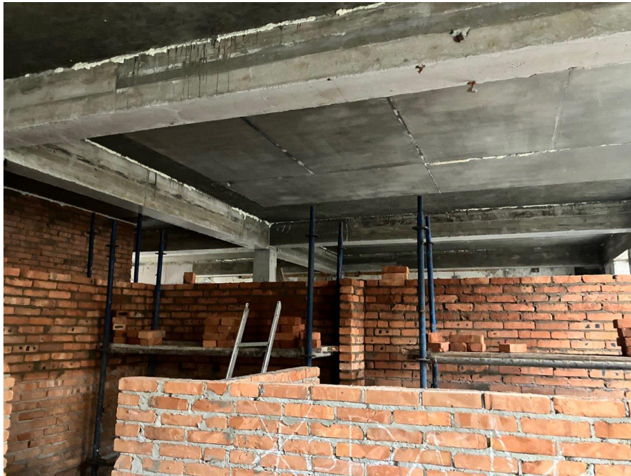
Рис. 5.1 Відновлення пошкодженого житлового в будинку місті Покровськ Херсонської області
