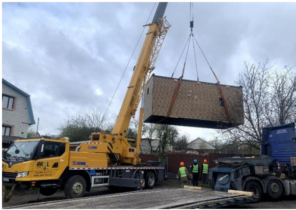
Рисунок 2.2 – Процес встановлення модульного будинку
