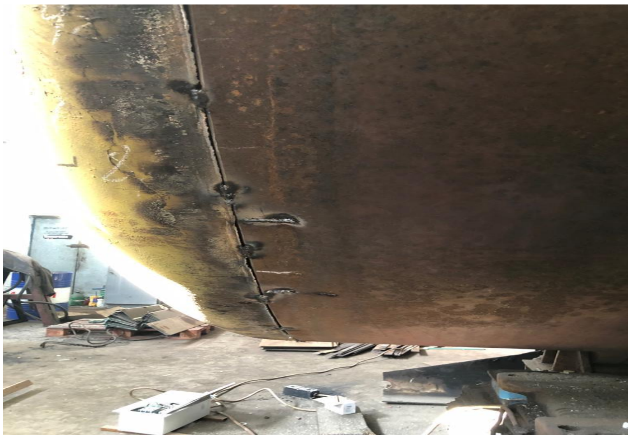
Рисунок 4.11. Попередній монтаж латок котла (на прихватках)
