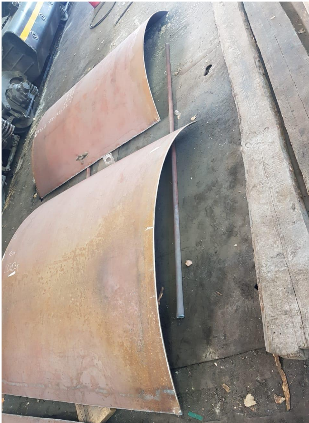
Рисунок 4.10. Метал для монтажу латок котла.
