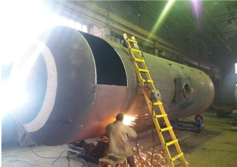
Рисунок 4.7. Різання дефектних ділянок котла на стенді- кантувачі №1
