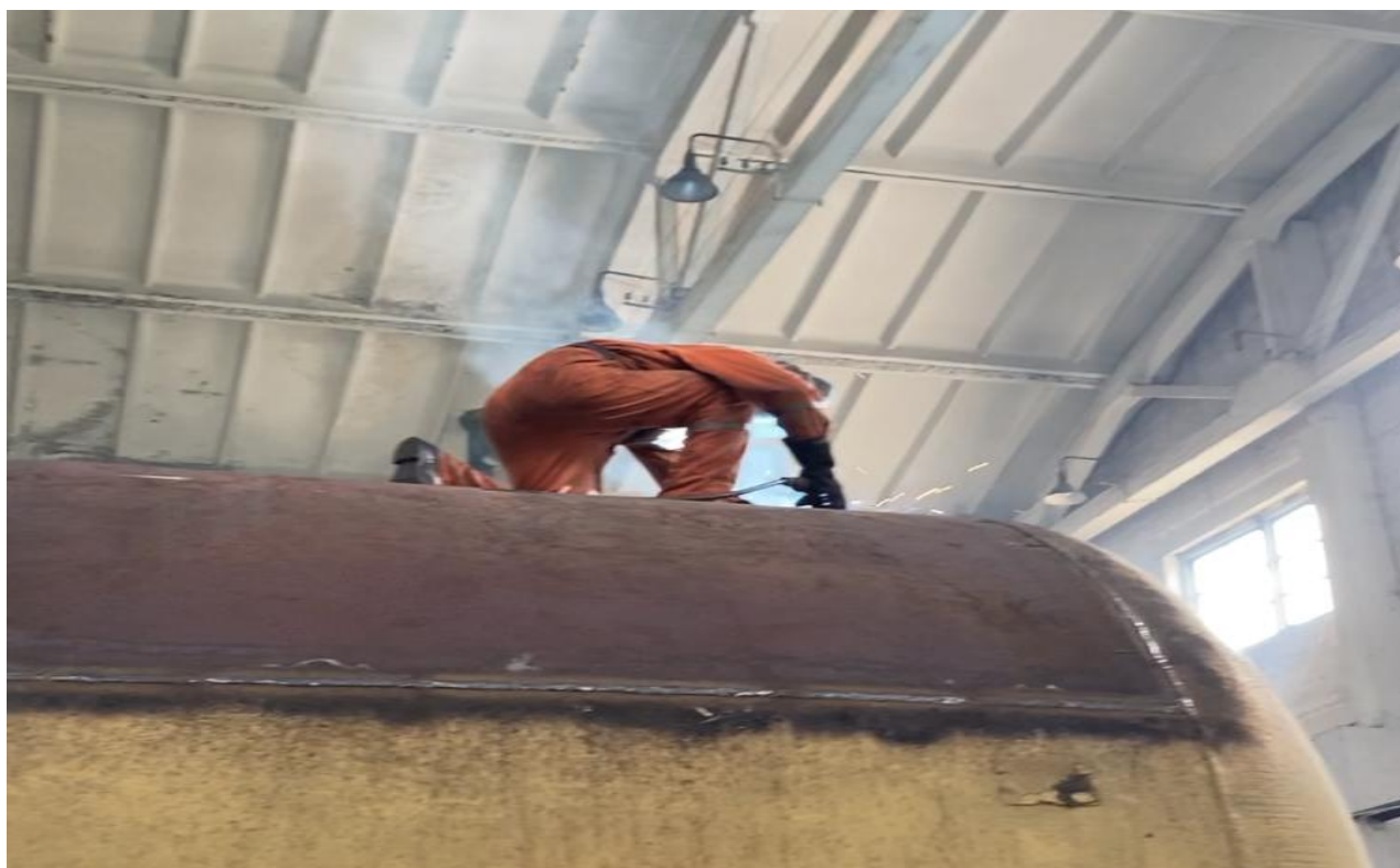
Рисунок 4.12. Остаточний монтаж латок котла (на прихватках)
