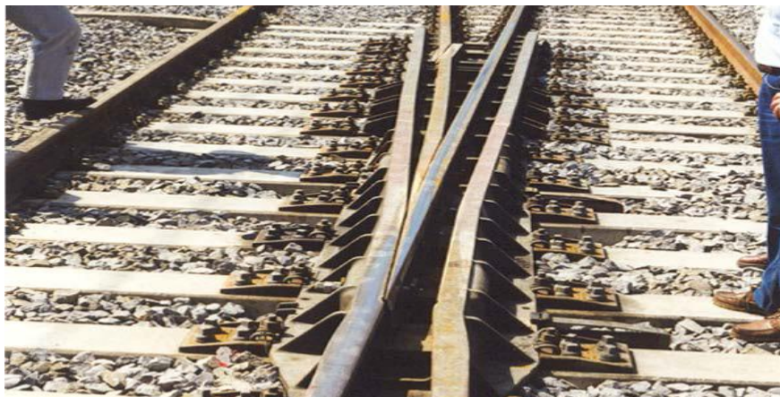
Рисунок 2.7 – Хрестовина із безперивною поверхнею кочення
