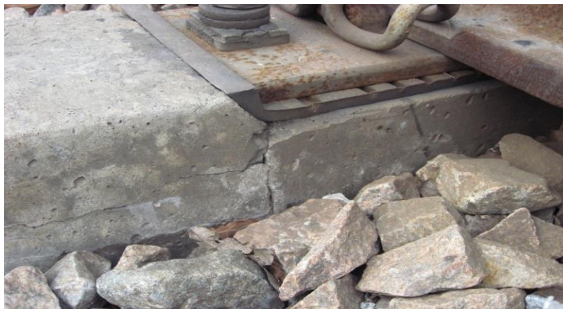
Рисунок 1.2 – Злом бруса у хрестовинному вузлі через підвищену динамічну дію при взаємодії рухомого складу із хрестовиною
