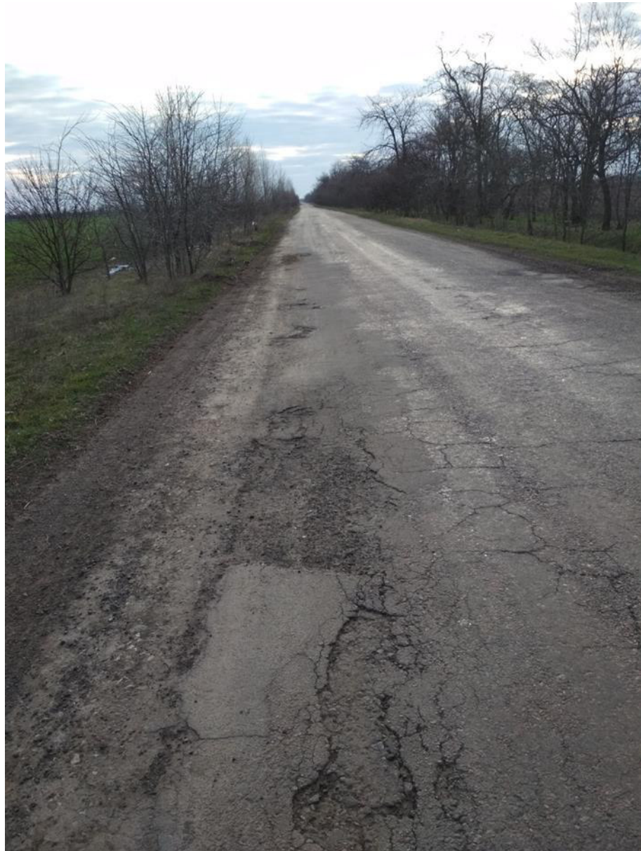
Рисунок 2.4 – Поперечні тріщини спричинені старінням асфальтобетону або використанням занадто в'язких бітумів.
