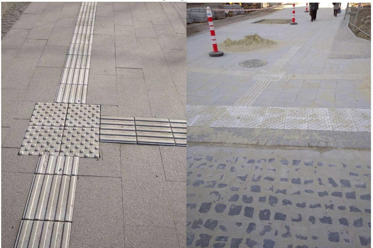
Рисунок 6. Зображення елементів інфраструктури з тактильною плиткою на пішохідних проходах згідно вимог інтероперабельності.
