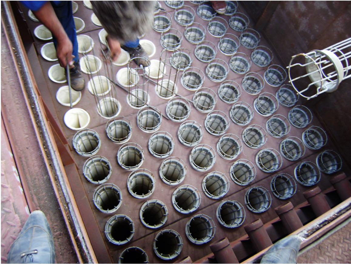
Рисунок 2.2. Встановлення рукавів в рукавний фільтр
