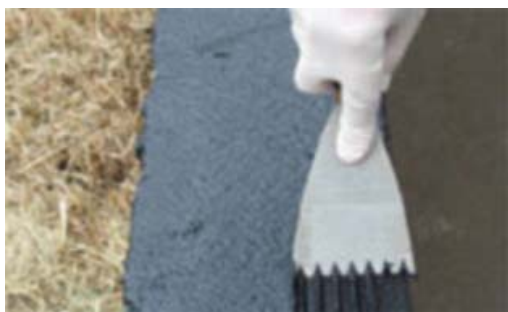
Рис. 5. Процесс нанесения клеевого состава на поверхность
