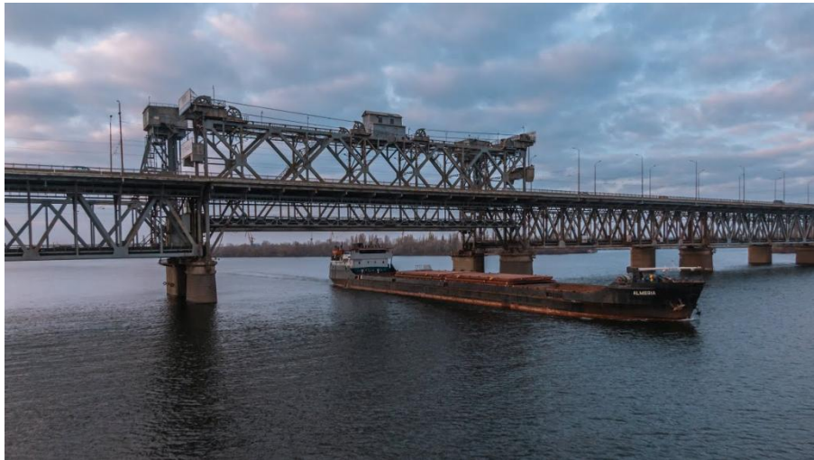
Рисунок 1.4 Двоповерховий міст через річку Дніпро (Дніпропетровськ) в процесі реконструкції. Загальна протяжність мостового переходу 2405,4 м. Міст без ремонту експлуатувався 47 років.
