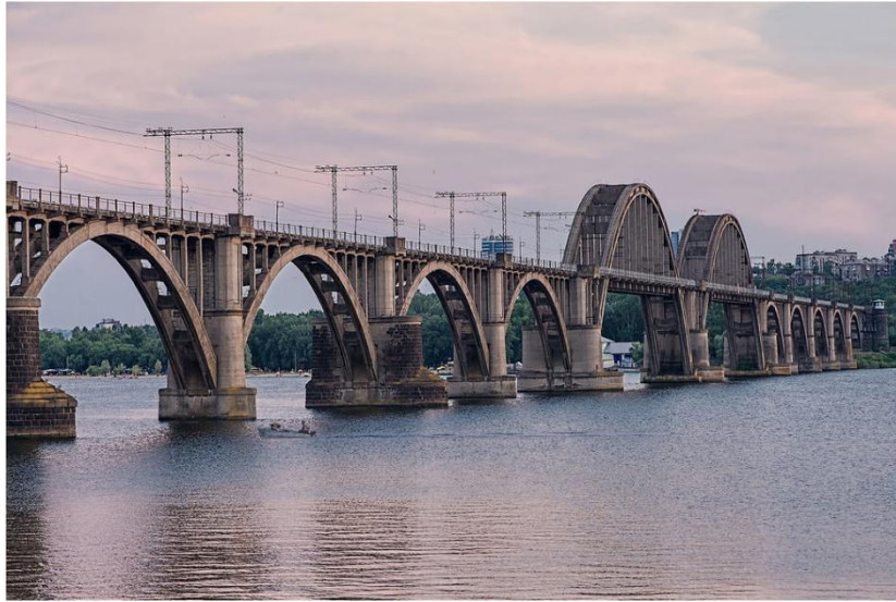
Рисунок 1.6.Залізничний міст через річку Дніпро (Дніпропетровськ) на магістралі Мерефа - Херсон.
