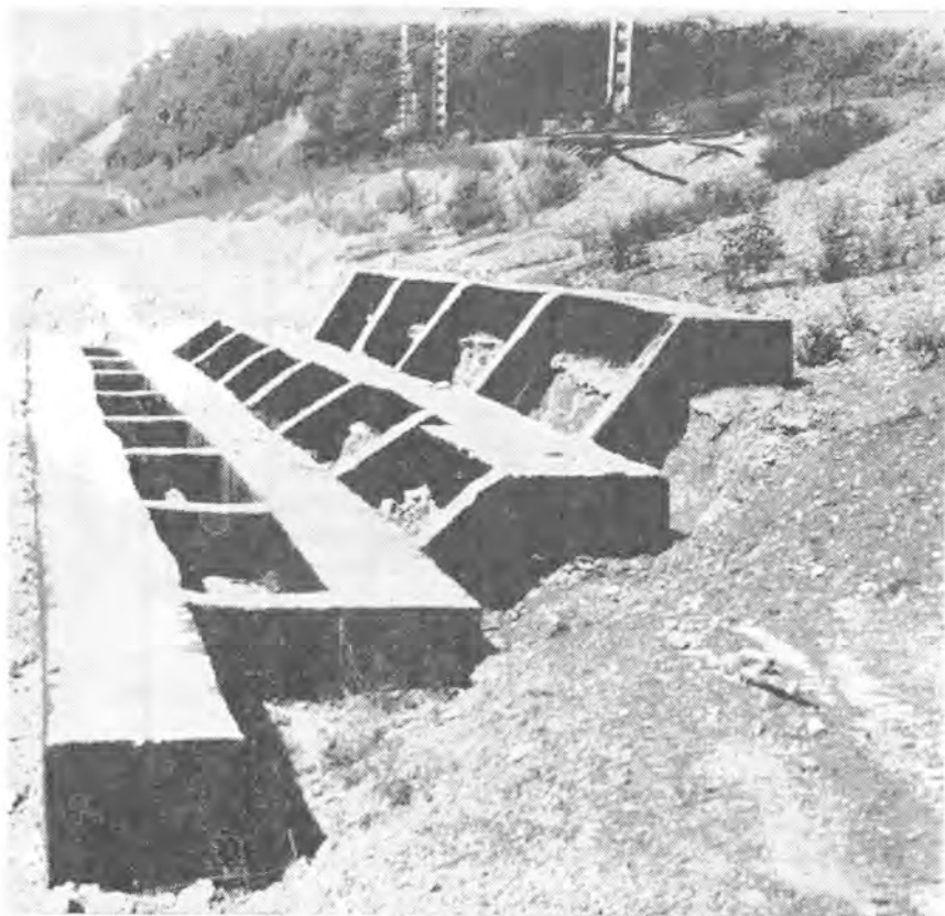
Рис. 12. Построенная противооползневая удерживающая конструкция глубокого заложения.
