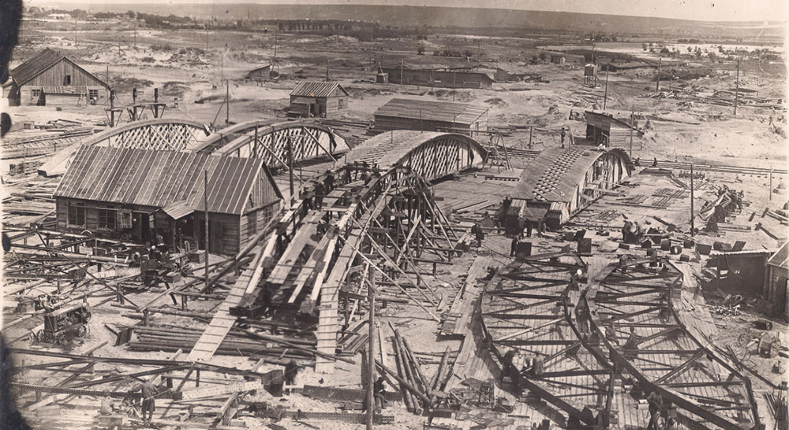
Изготовление металлич. и досчатых кружал на левом берегу
