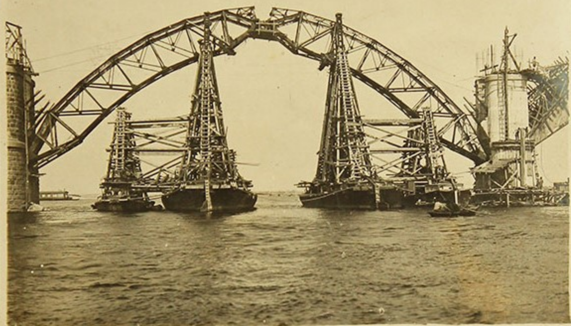
Конец постройки металлических кружков
