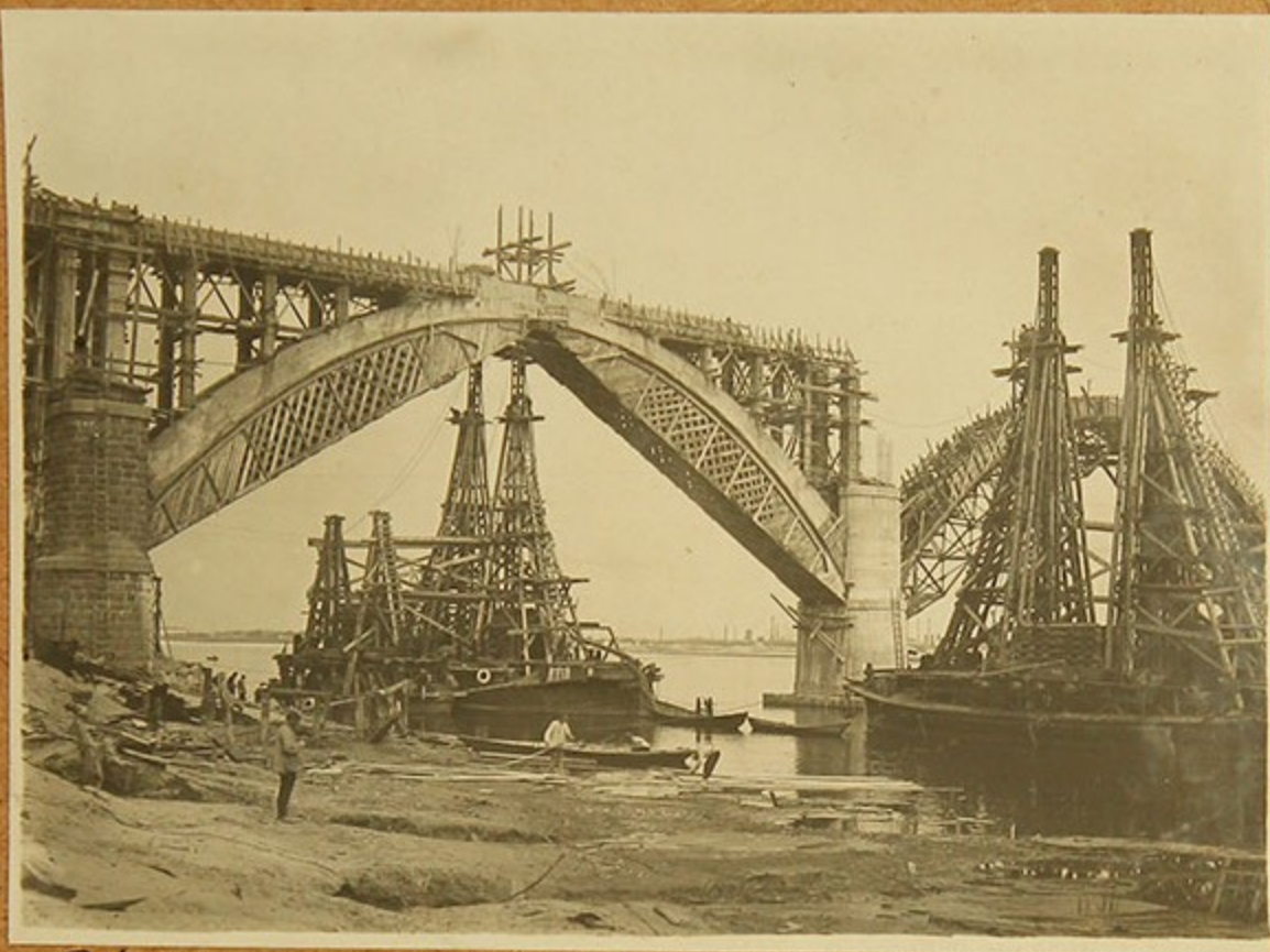
Съемка досчатых кранов плав. краном в ретивых пролетах
