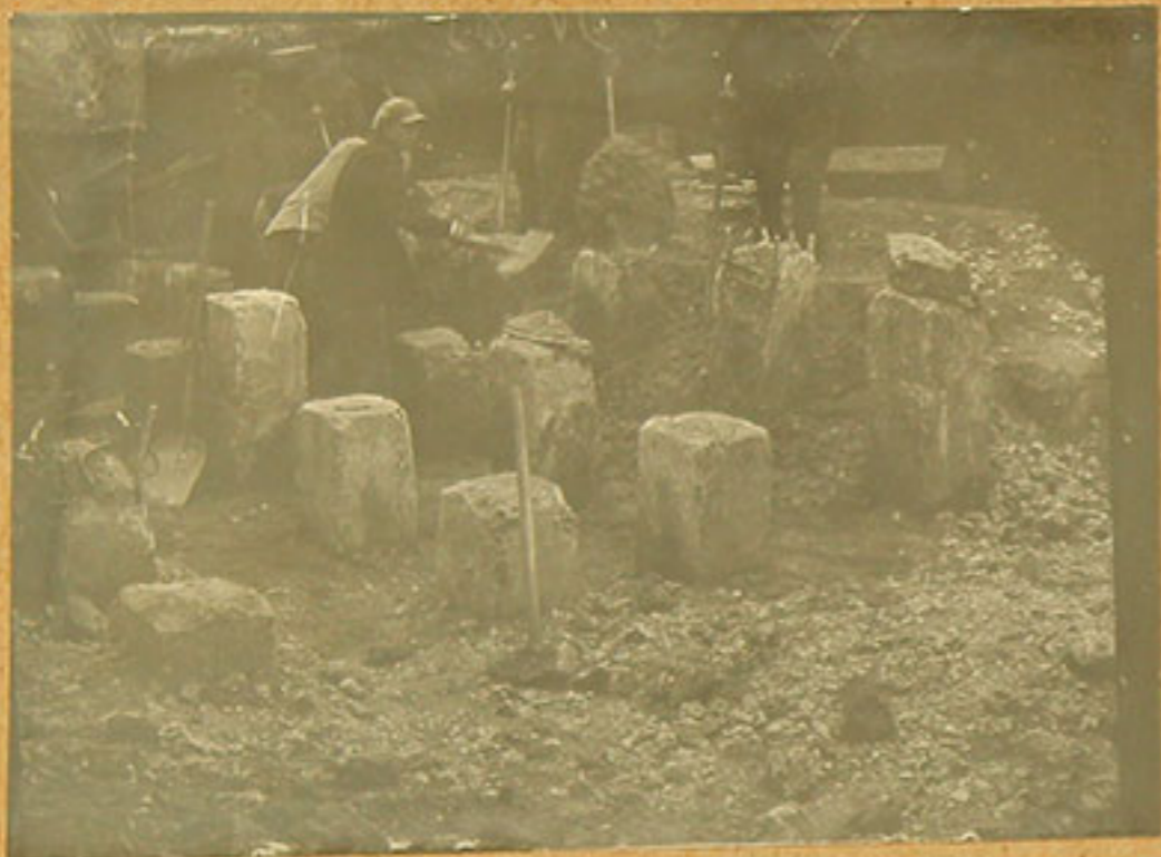
Удаление старой кладки разобранной опоры
