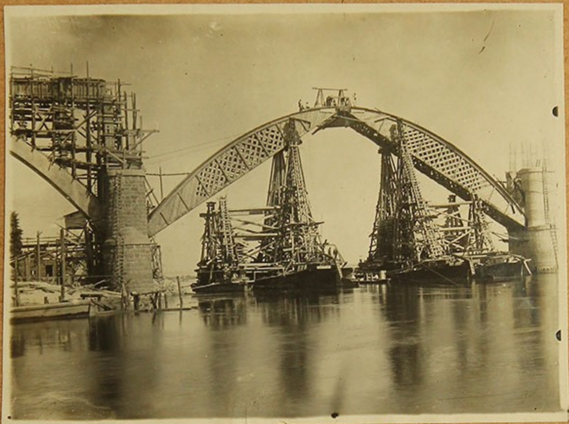
Конец подвиги досельных кранов плов. кранов
