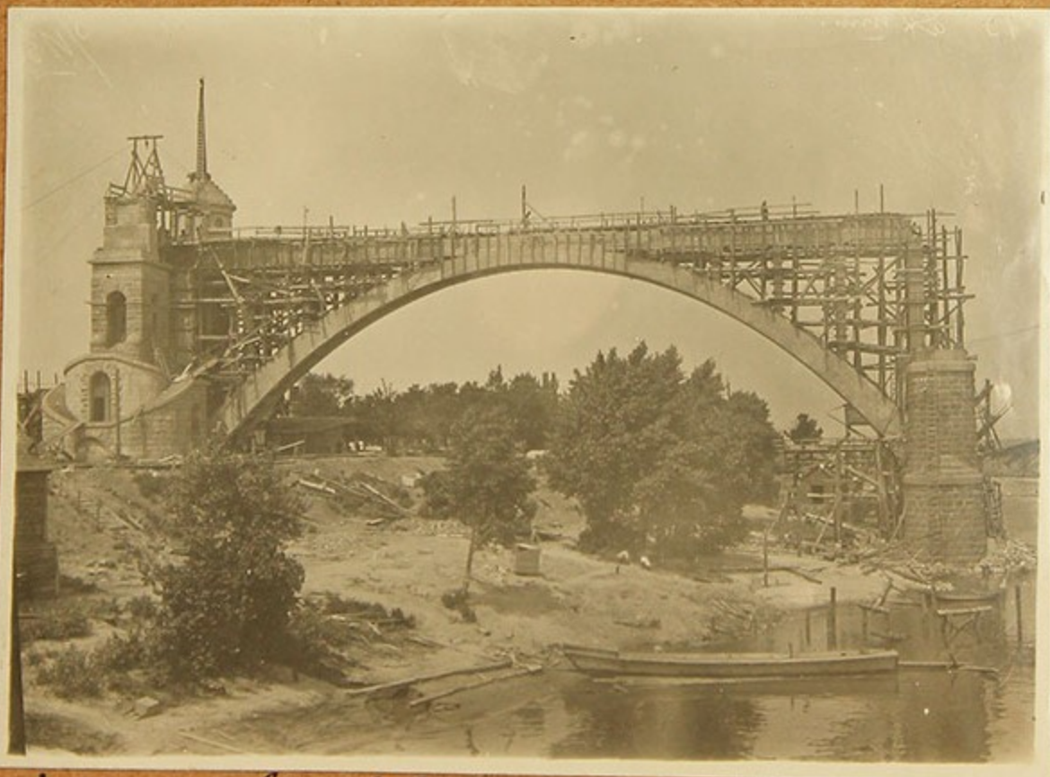
Забетонированная арка и устройство надарочного строения
