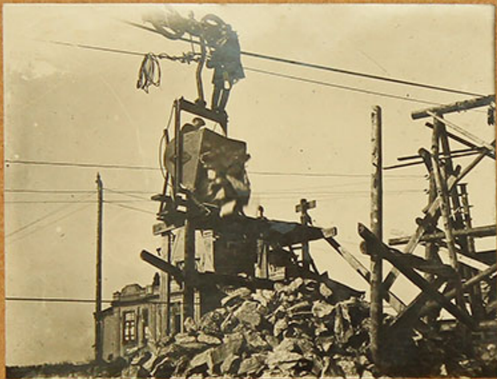
Возгрузка камня из плотины под бесчой горюхи Капел - остров
