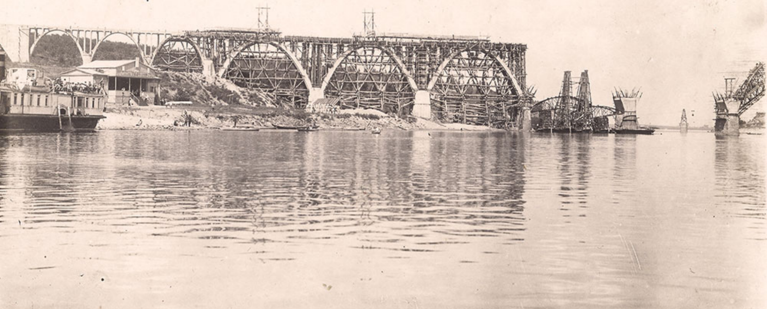
Вид забетонированных арок прав. бер. части моста
