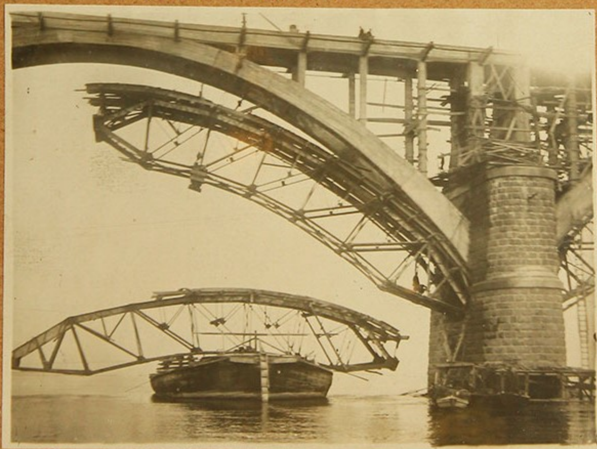
Съемка металл. кранов в кран. пролетах
