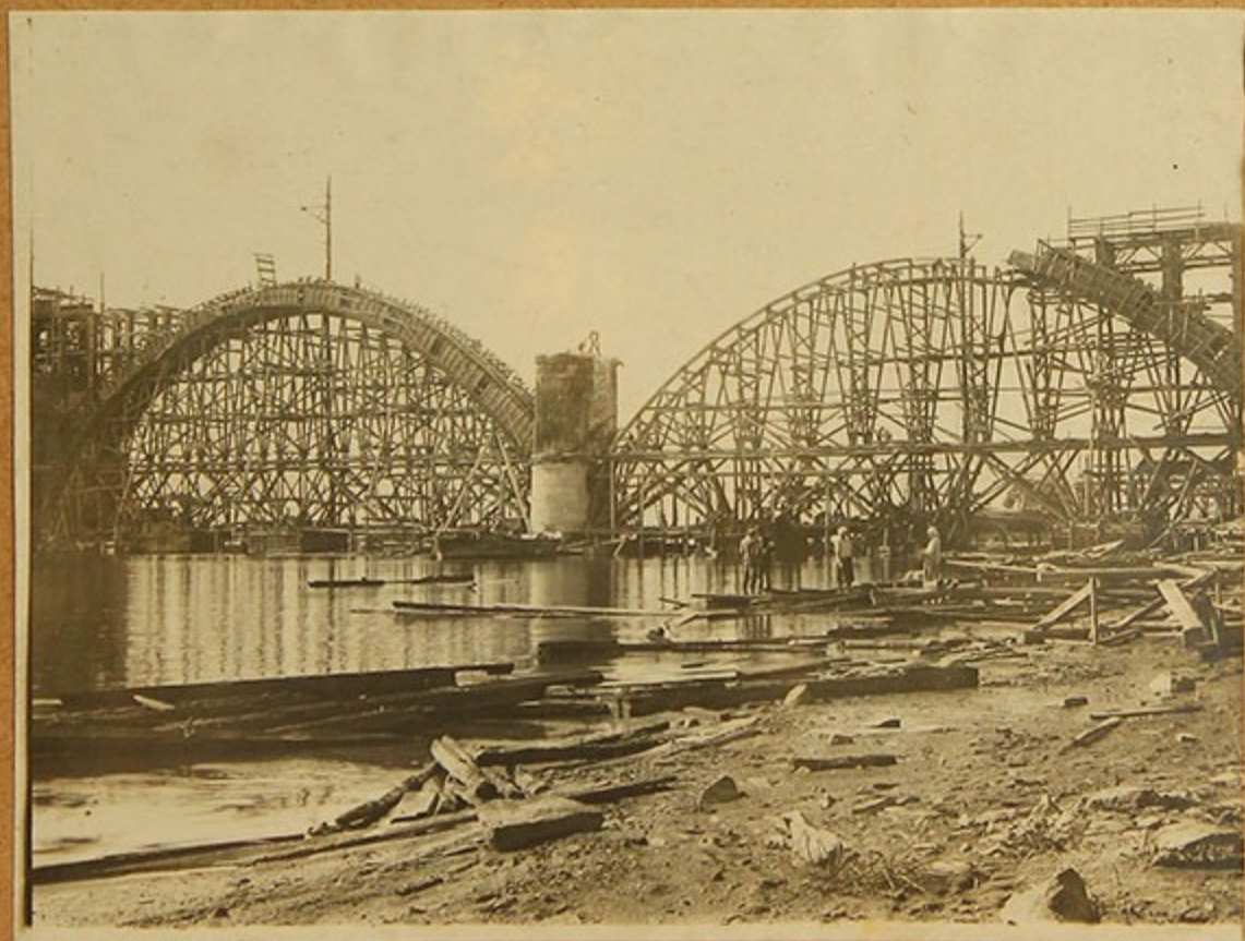
Восстановление кружака после пожара
