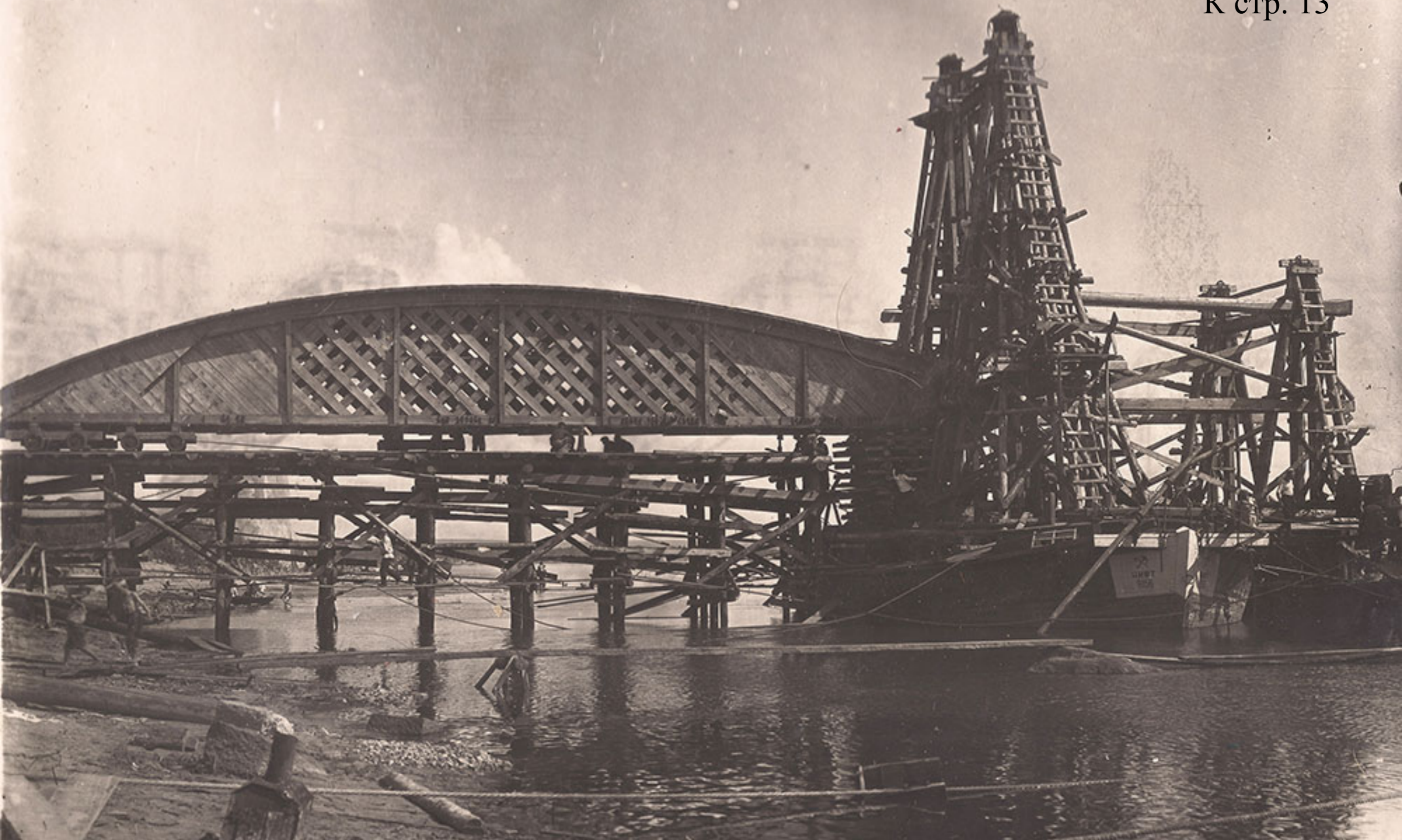
Погрузка досчатой полуфермы на плав. кран Артем Костюк | artkostyuk.com Из коллекции Нурии Бусыгиной
