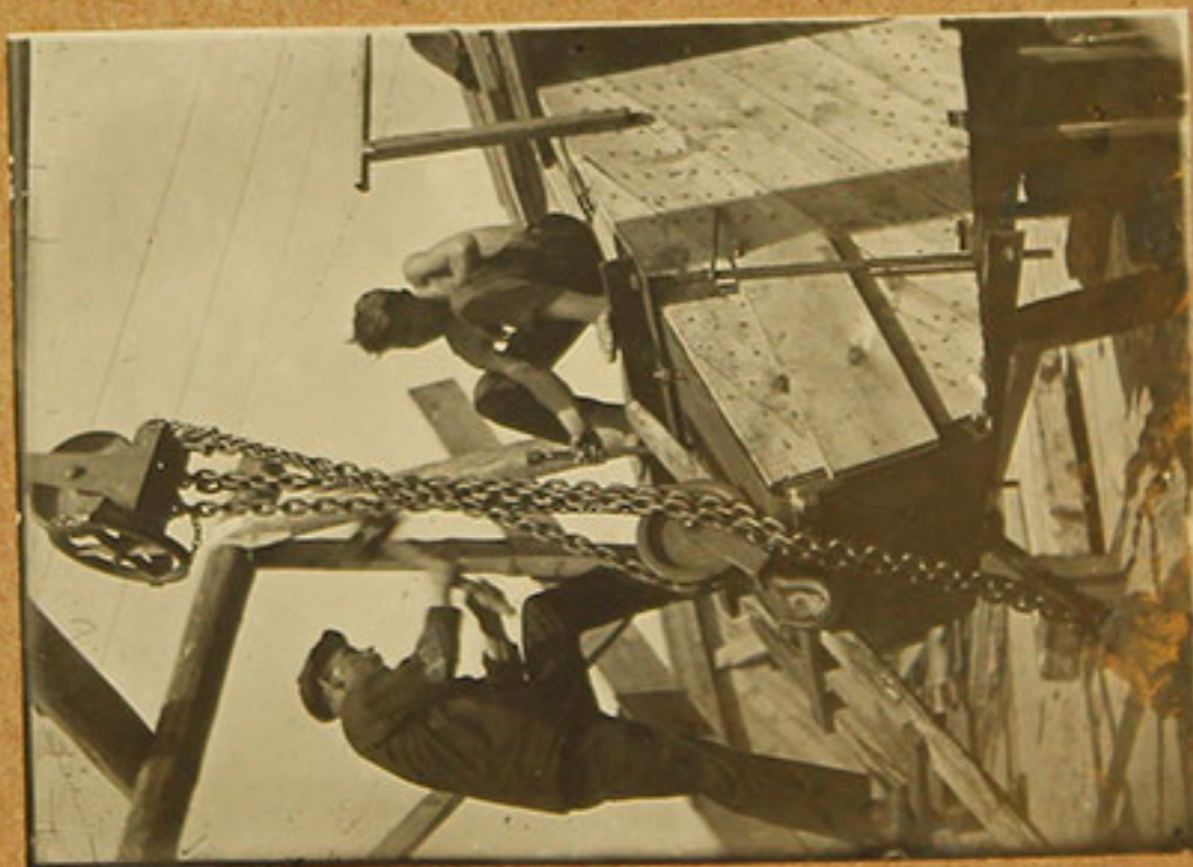
Надевание металлол. наконечника на опорную часть досчатых Круша
