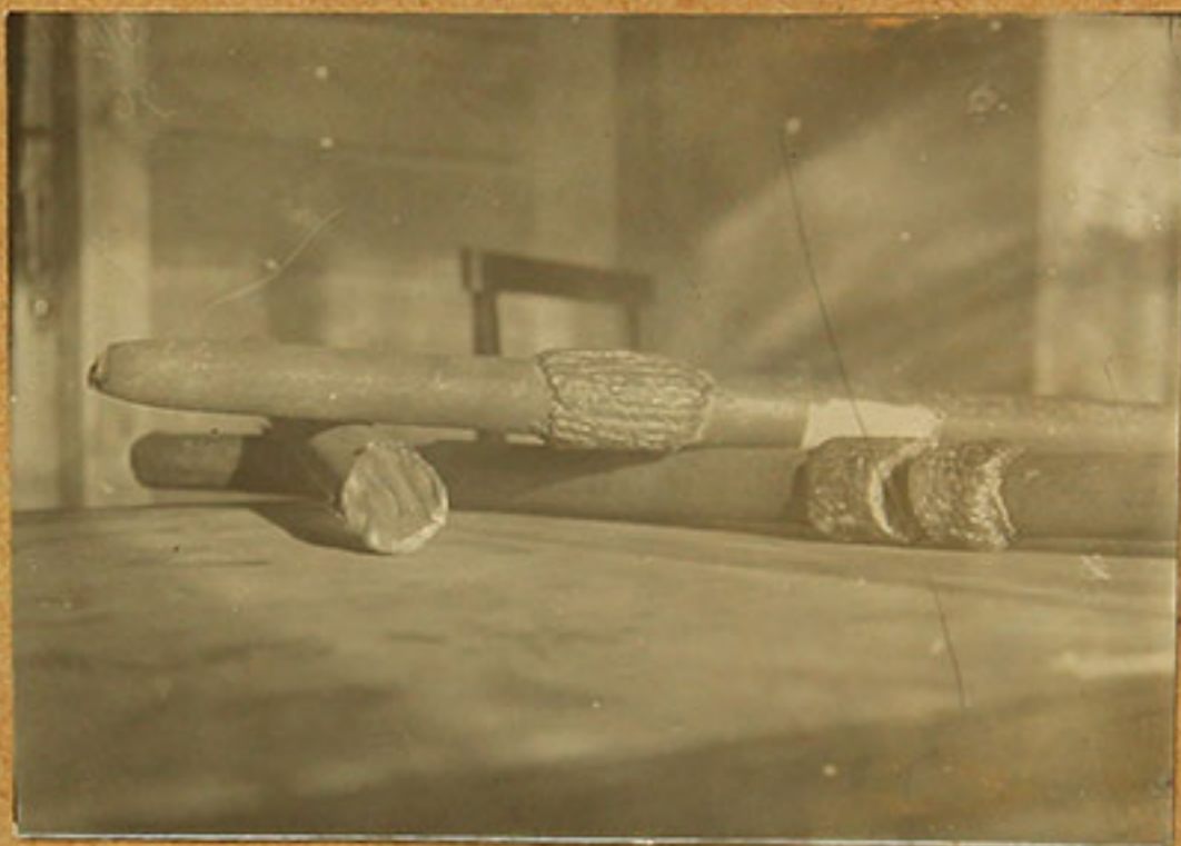
образцы сварных стыков арматуры
