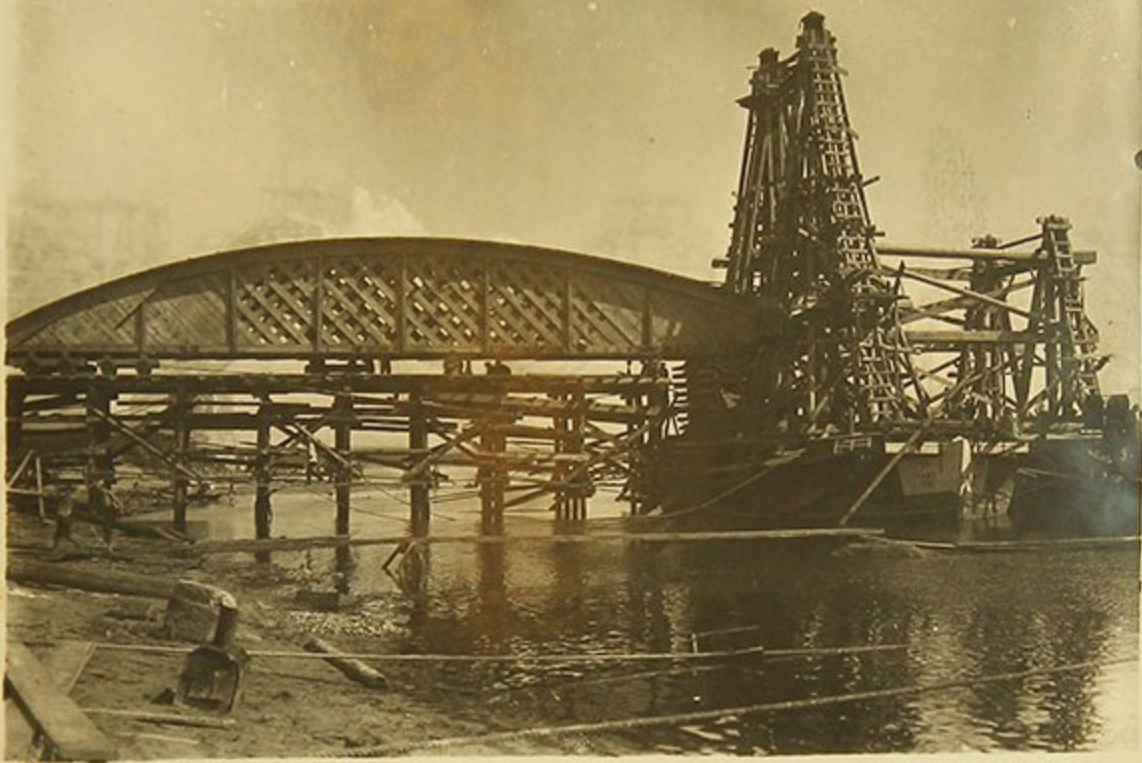
Погрузка досчатой палубермы на плавкраны
