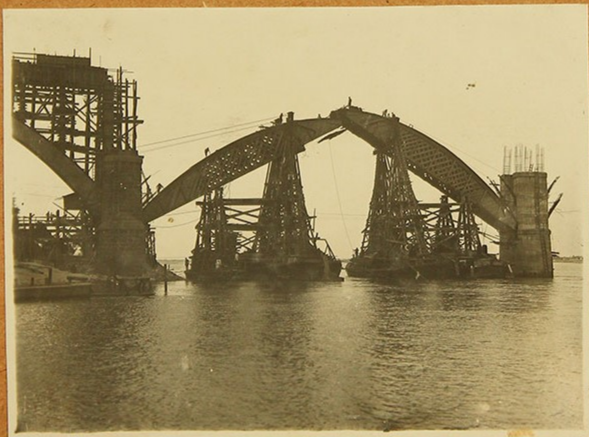
подъемка досчатых кружал плавучими кранами
