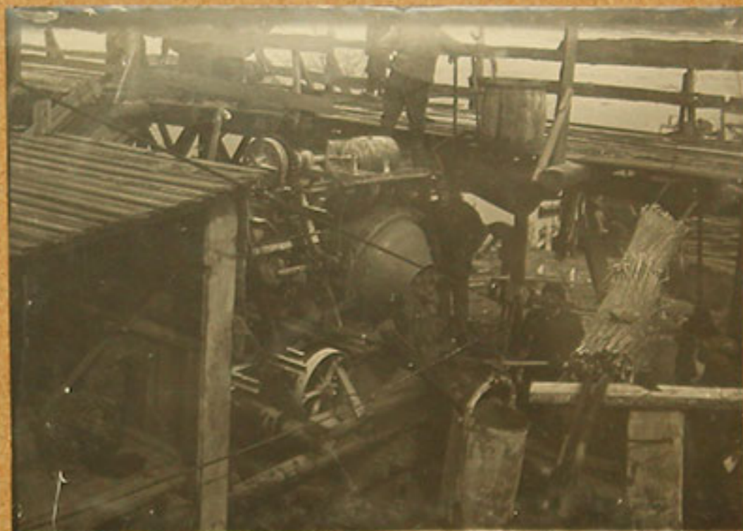
Приготовление смеси бетона для бетонирования пролета в аэродроме
