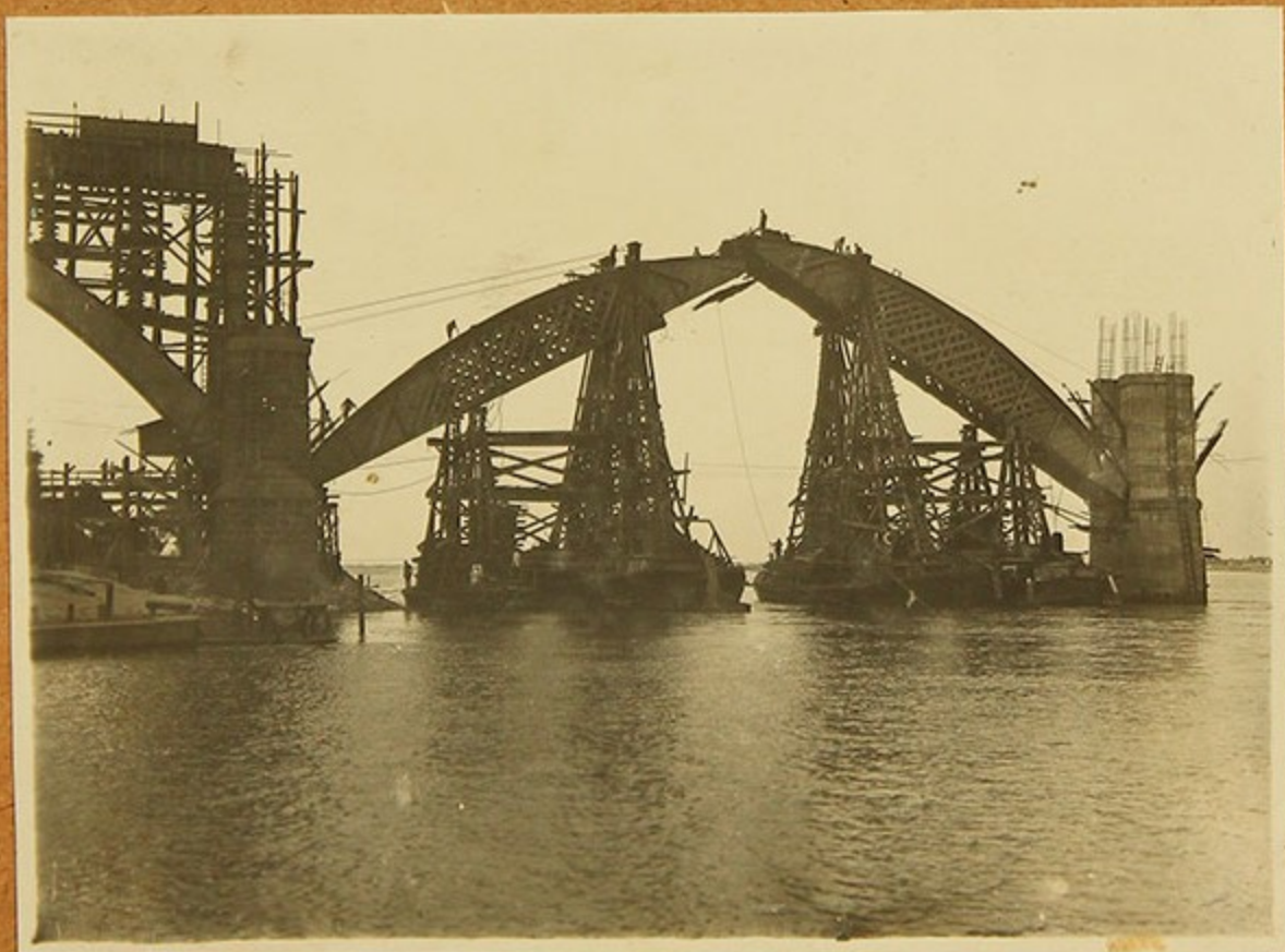
подъемка досчатых кружал плавучими кранами
