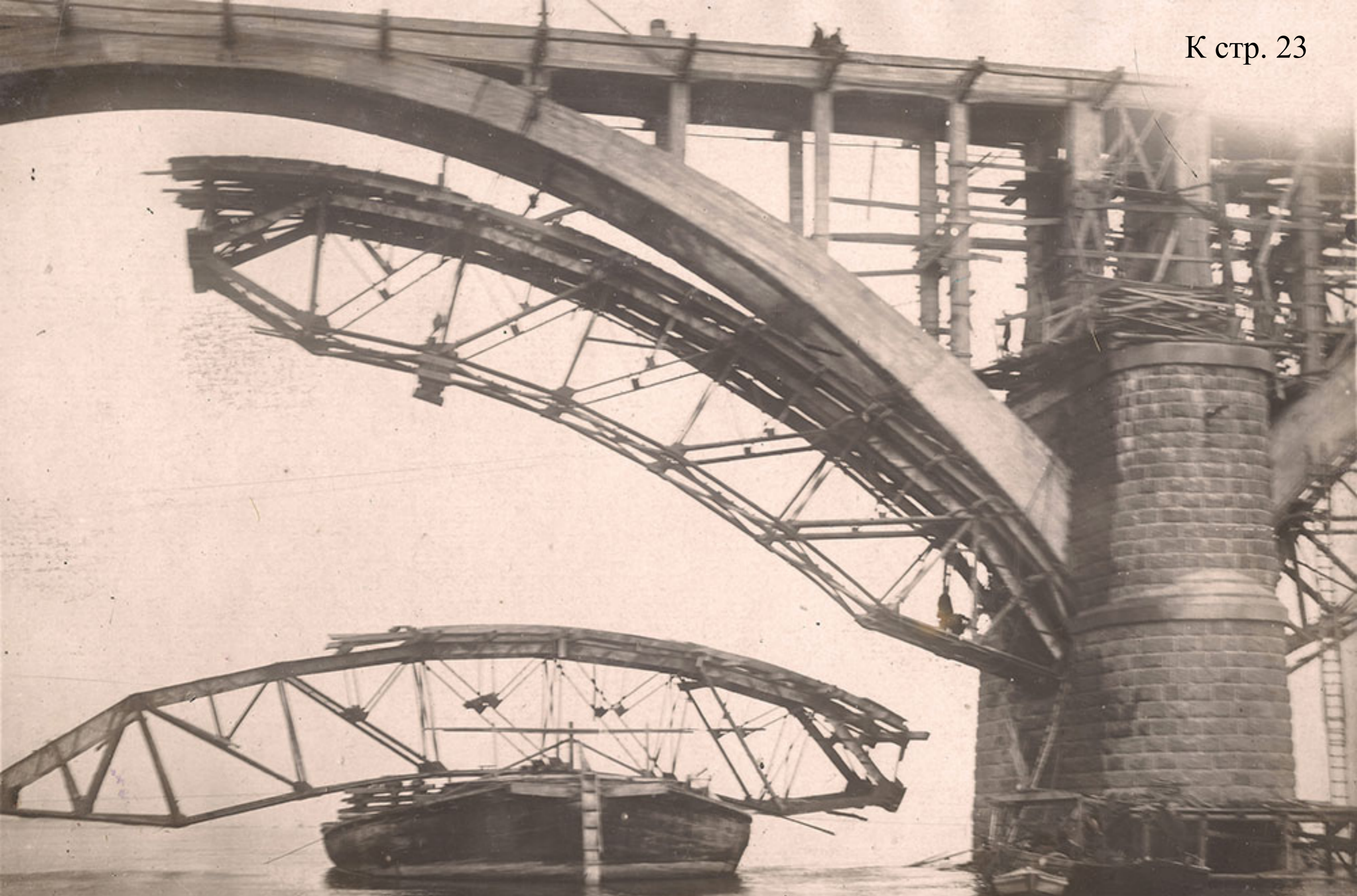
Съемка металлич. кружал в прол. протока
