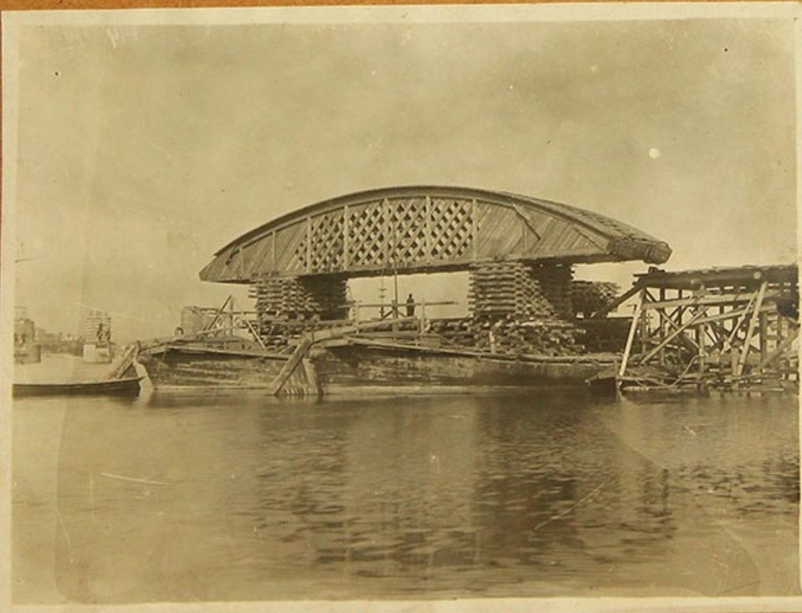
Досчатая палуберма на барже для подъема в реку проп. мартв. дносью
