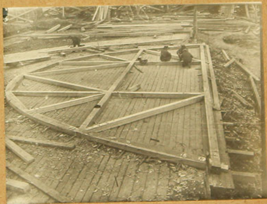
Изготовление кривой на плазу сводов L=15 мт прав. бережн. части моста
