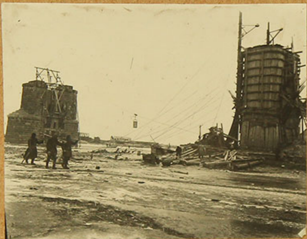
Опоры в Илоупуэро и Работа кран для бетонировки внутри ветряной опоры
