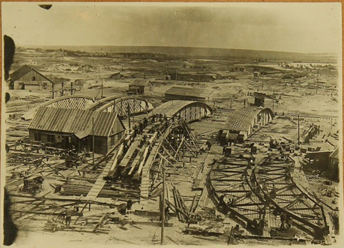
Изготовление металл. и железных крестов на левом берегу
