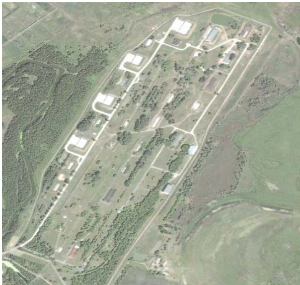
Рис. 2. Здания – хранилища с твердым ракетным топливом на территории Павлоградского химического завода
