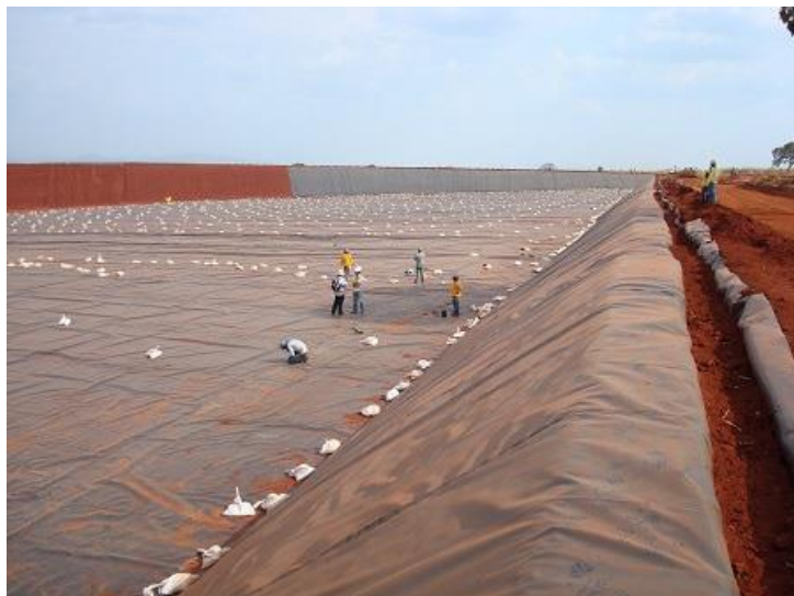
Рис. 6. Підготовка ділянки сучасного полігону для захоронення відходів
