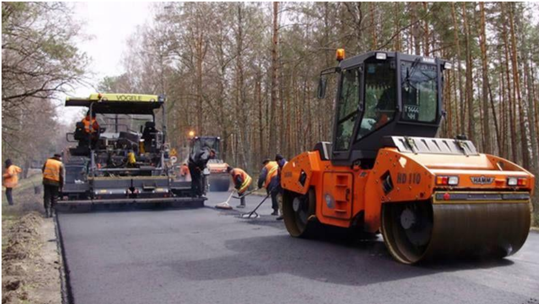
Рисунок 4.1 – Робота машин під час будівництва автомобільної дороги
