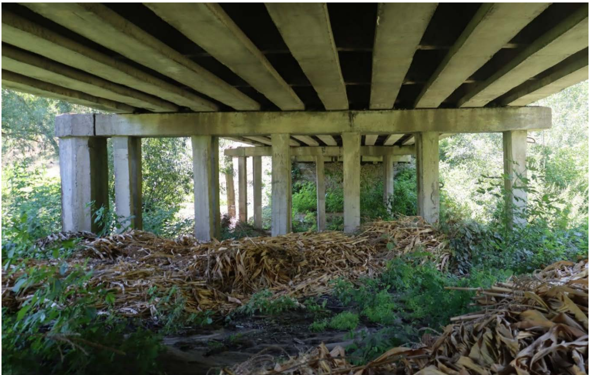
Рис. 1.5. Загальний вид проміжної опори №1 (вид зі сторони опори №0)
