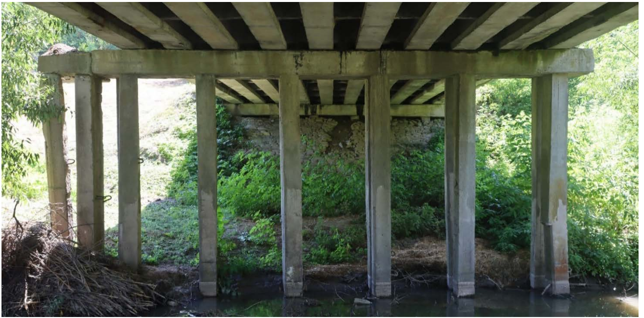
Рис. 2.13. Сліди вилуговування і діяльності мікроорганізмів на поверхні ригеля та палі опори № 2
