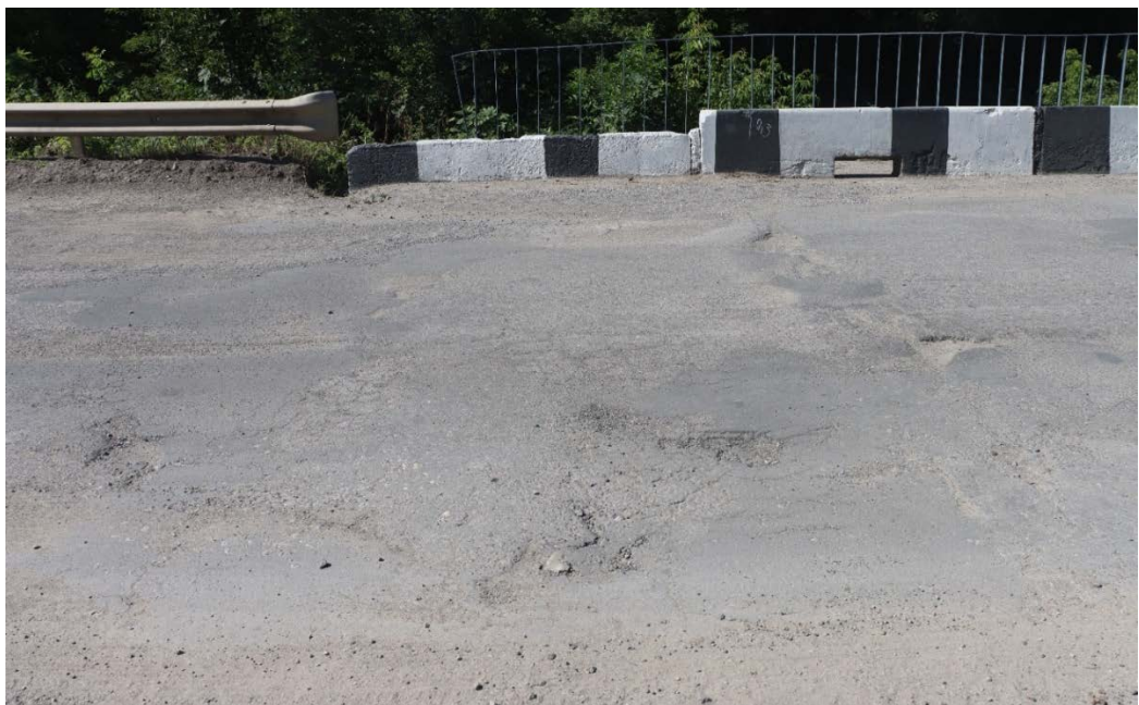
Рис. 2.35. Відсутність плавного заїзду на міст зі сторони м. Могилів-Подільський
