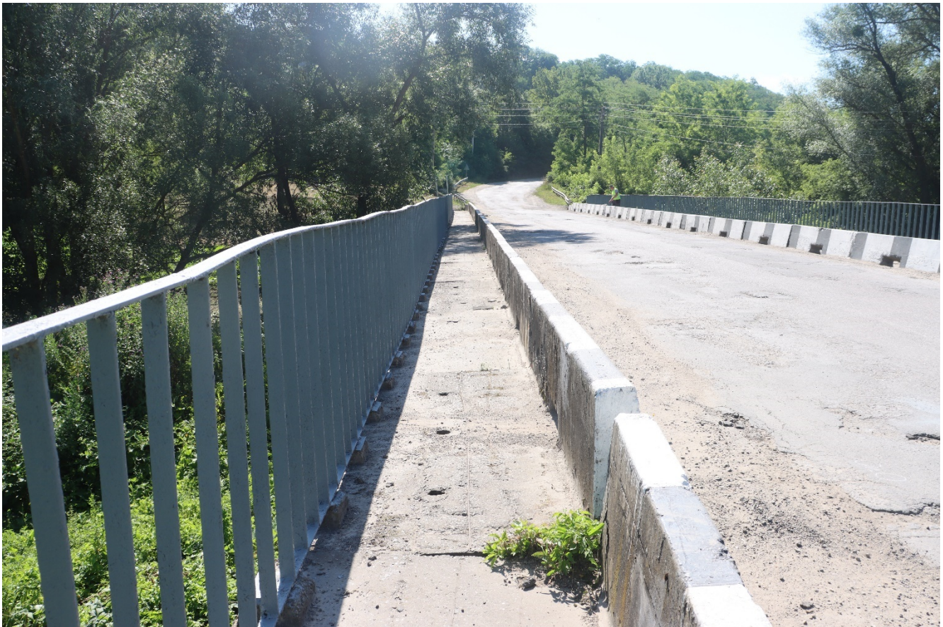
Рис. 1.7. Транспортне і поручневе огороження ліворуч по ходу кілометрів
