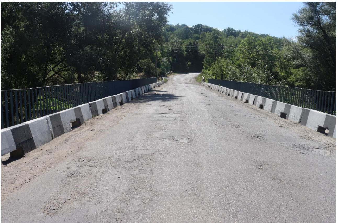
Рис. 1.6. Загальний вид на проїзну частину мосту
