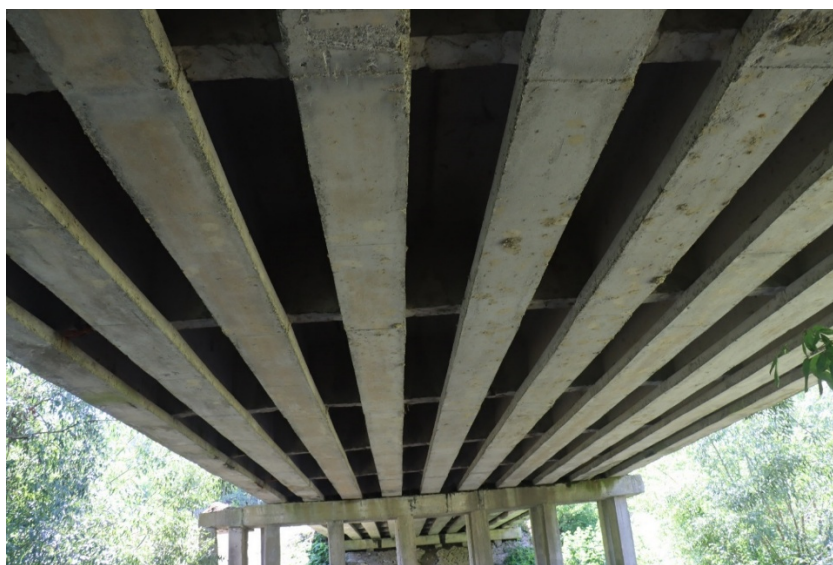
Рис. 1.3. Вид на прогонову будову 1-2 знизу та проміжну опору №2
