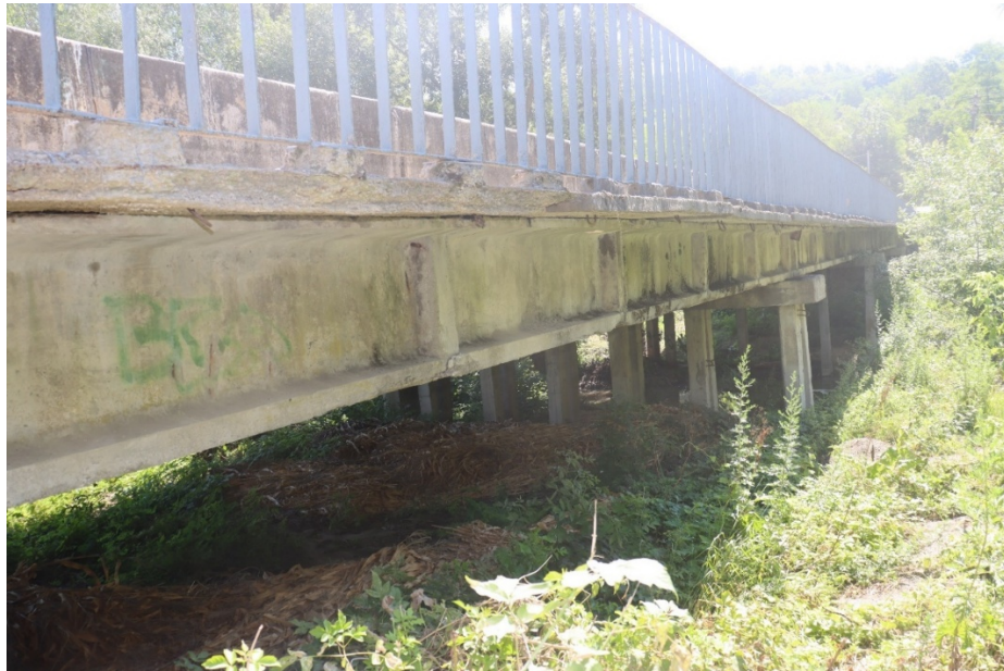
Рис. 1.1. Загальний вид мосту праворуч по ходу кілометрів
