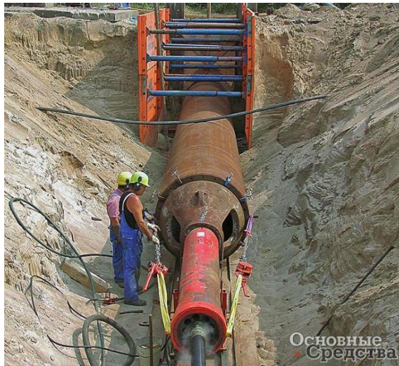
Рис. 1.7. Схема забивання труб діаметром 1000 мм, пневмоударною машиною М400
