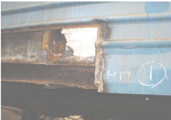
Рис. 4. Обрив стійки
