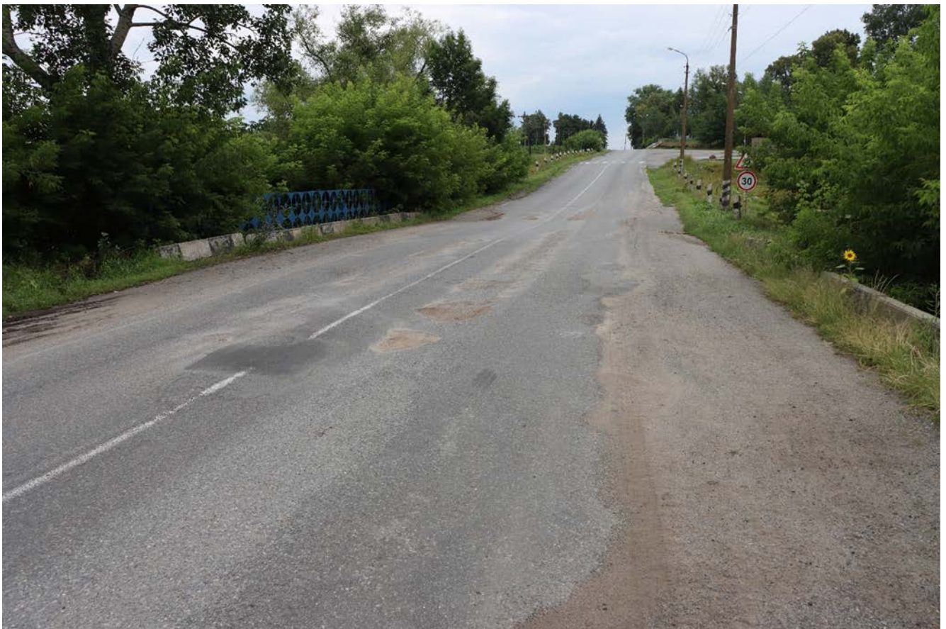
Рис. 1.5. Загальний вид на проїзну частину мосту
