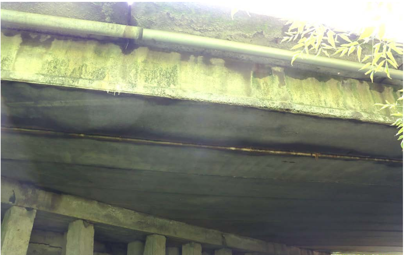
Рис. 1.3. Вид на прогонову будову 0-1 знизу
