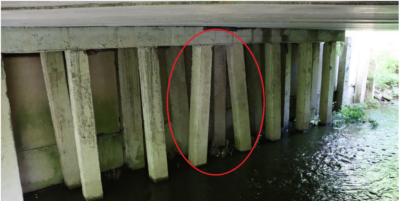
Рис. 2.15. Відхилення палі П9, П10 опори №1 від проектного положення
