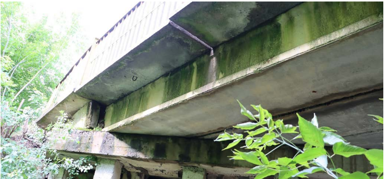
Рис. 2.1. Патьоки брудного та зеленого кольору по боковій поверхні плит П1 прогонової будови 0-1.
