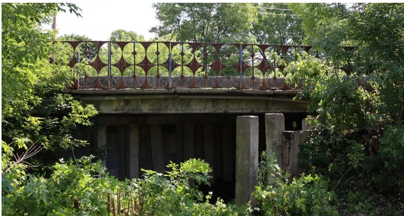
Рис. 1.1. Загальний вид мосту праворуч по ходу кілометрів
