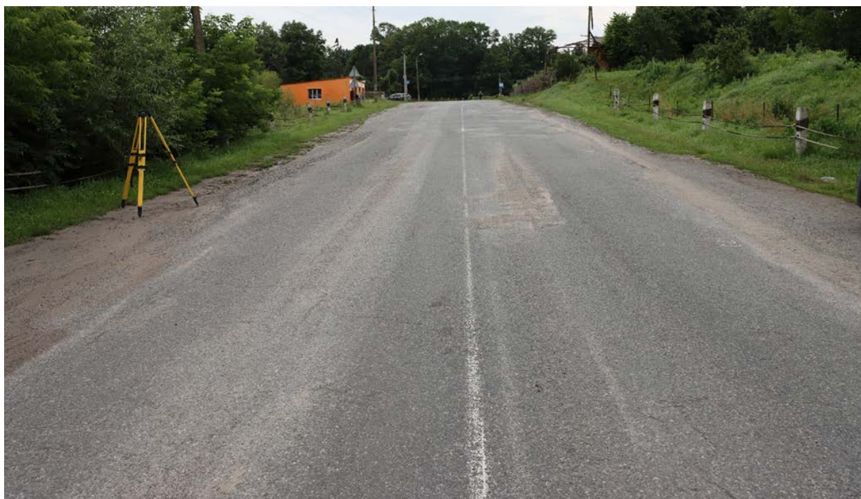
Рис. 1.8. Підхід до мосту зі сторони м. Чернівці
