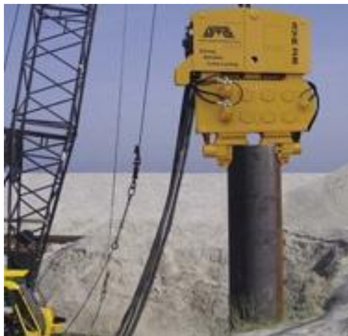
Рис. 13.5. Занурення паль вібромолотом
