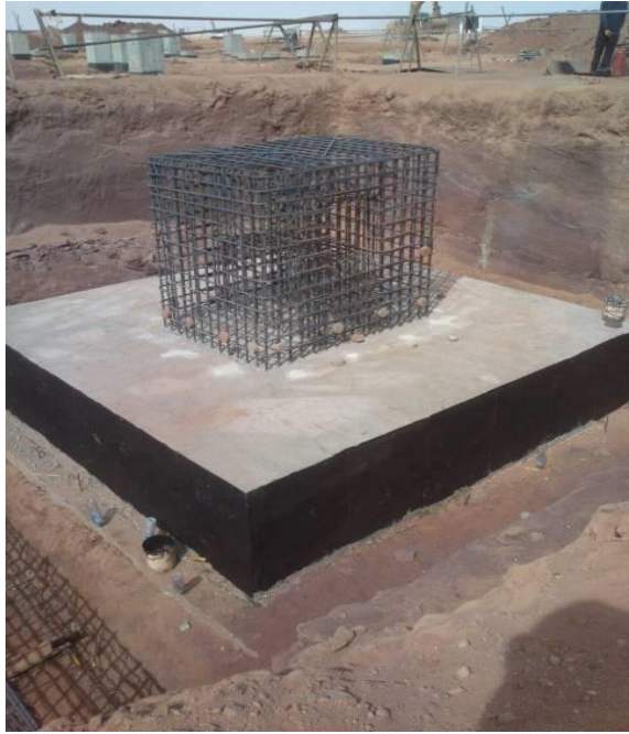
Рис. 6.16. Фото забетонованого фундаменту
