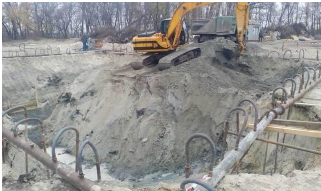
Рис. 8.2. Одноярусне глибинне водозниження котлованів
