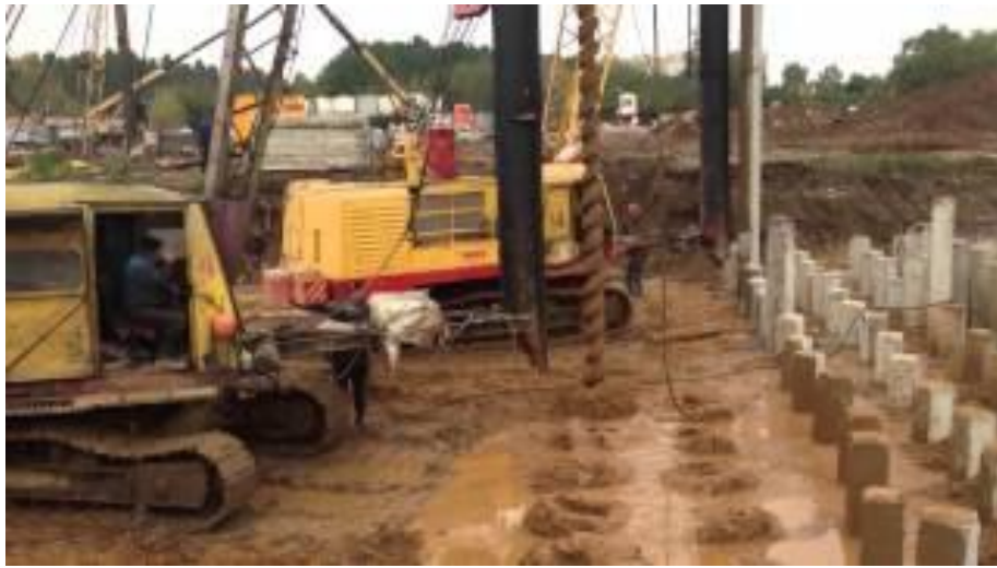
Рис. 13.4. Буріння лідируючої свердловини
