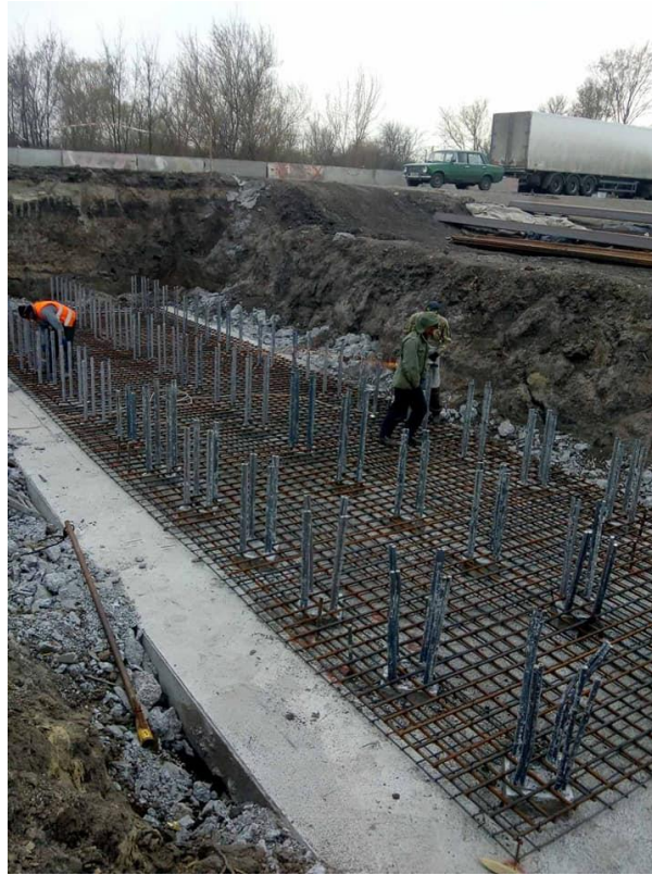
Рис. 14.4. Роботи з армування ростверку пальового фундаменту
