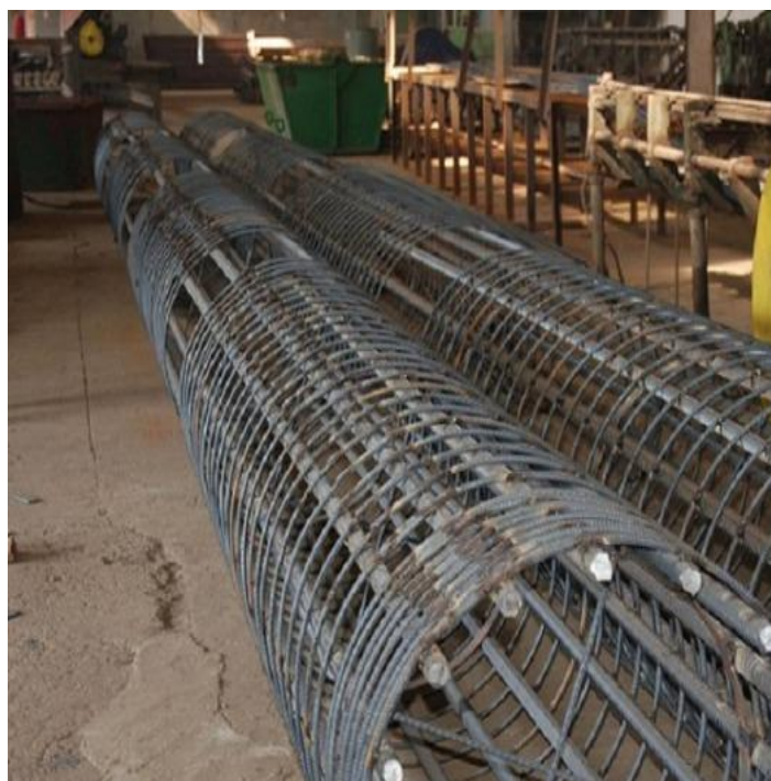
Рис. 13.7. Арматурний каркас буронабивної палі
