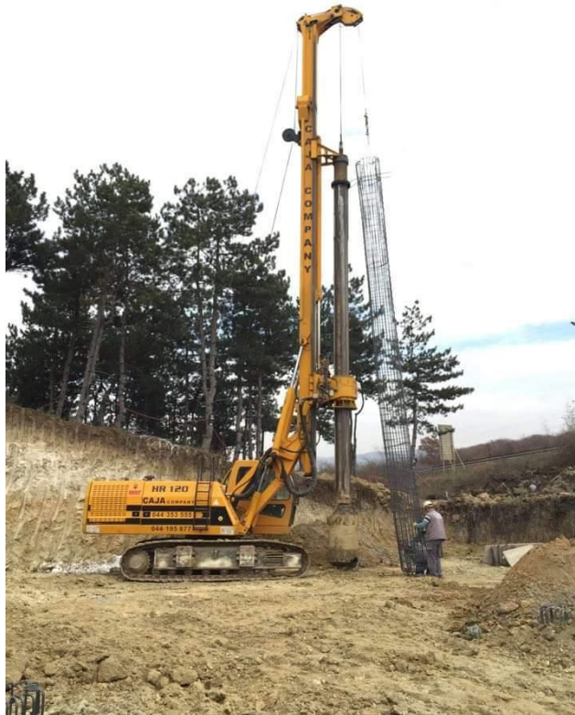
Рис. 14.3. Установа для спорудження буронабивних паль
