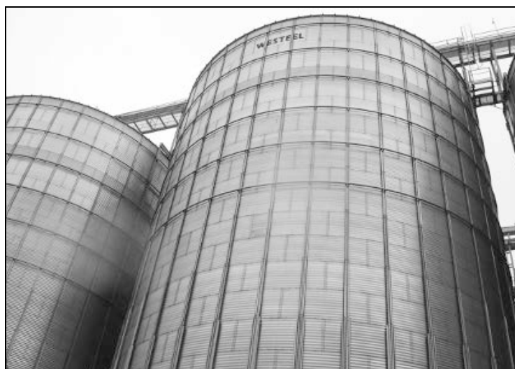
Рис. 1.15. Внешнее размещение «ветровых колец»
