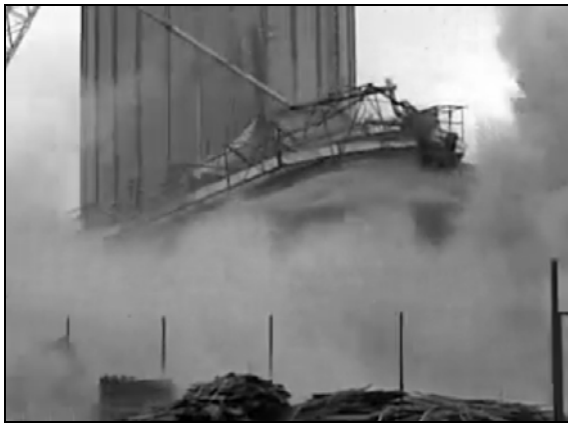
Рис. 1.28. Авария силосной емкости с гофрированной стенкой (фрагменты): а) – е) этапы разрушения
