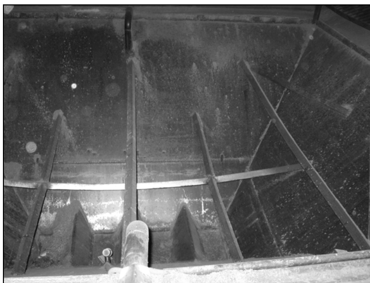
Рис. 1.20. Погнутости усиливающих стальных тяжей разгрузочной воронки емкостной конструкции
