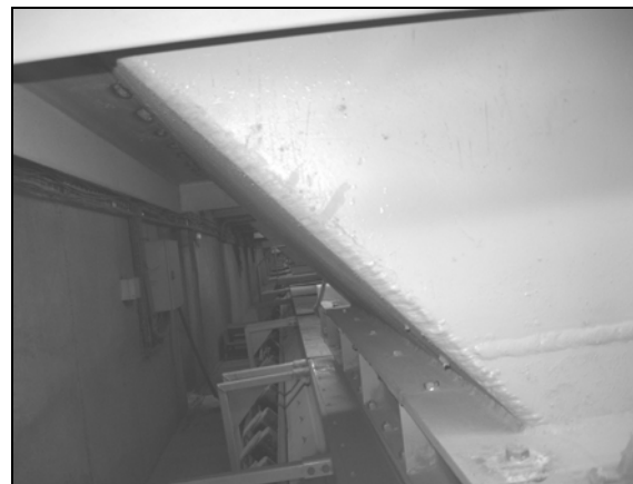
Рис. 1.19. Погнутости несущих элементов разгрузочной воронки емкостной конструкции: а) выгибы ребер жесткости, б) выгиб стенки
