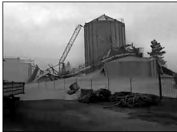
Рис. 1.28. Авария силосной емкости с гофрированной стенкой (фрагменты): а) – е) этапы разрушения
