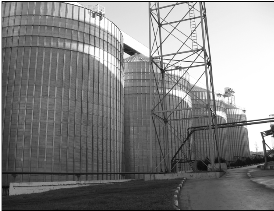
Рис. 1.18. Внешний вид вертикальной части силосов
