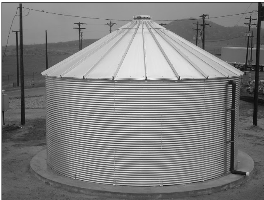
Рис. 1.14. Общий вид стальной силосной емкости с гофрированной стенкой
