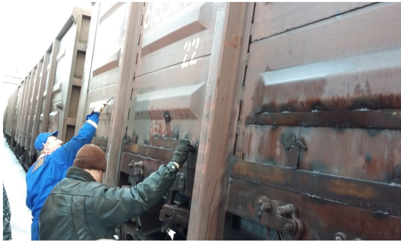
Рисунок Д.1 – Виконання ультразвукової товщинометрії несучих конструкцій кузова піввагона
