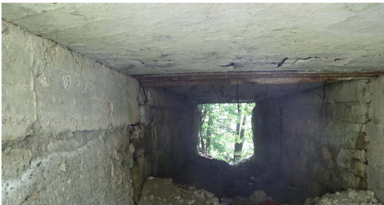
Рис. 1.3. Вид на прогонову будову 0-1 знизу
