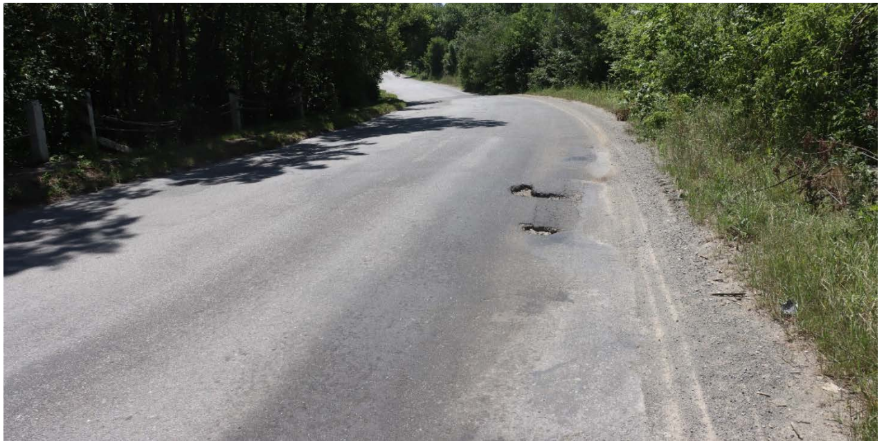
Рис. 1.5. Загальний вид на проїзну частину мосту зі сторони м. Дунаївці
