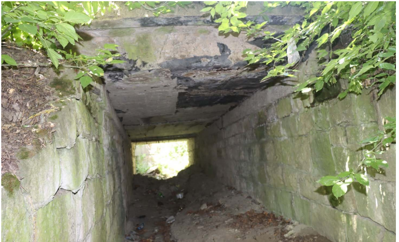
Рис. 1.1. Загальний вид мосту ліворуч по ходу кілометрів
