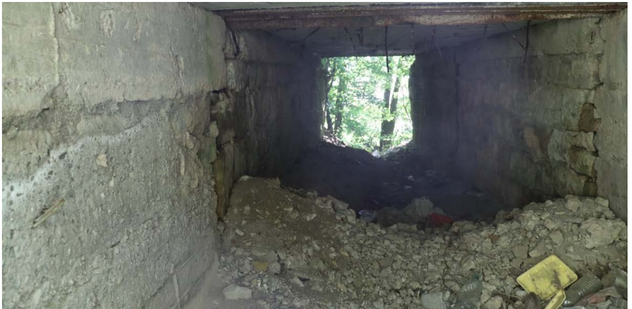
Рис. 2.15. Завал підмостового простору камінням та сміттям.
