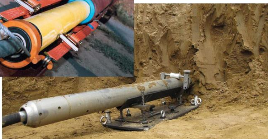
Рис. 1.4. Використання пневмопробійника при прокладенні підземних комунікацій: а – створення пілотної свердловини; б – забивання труб
