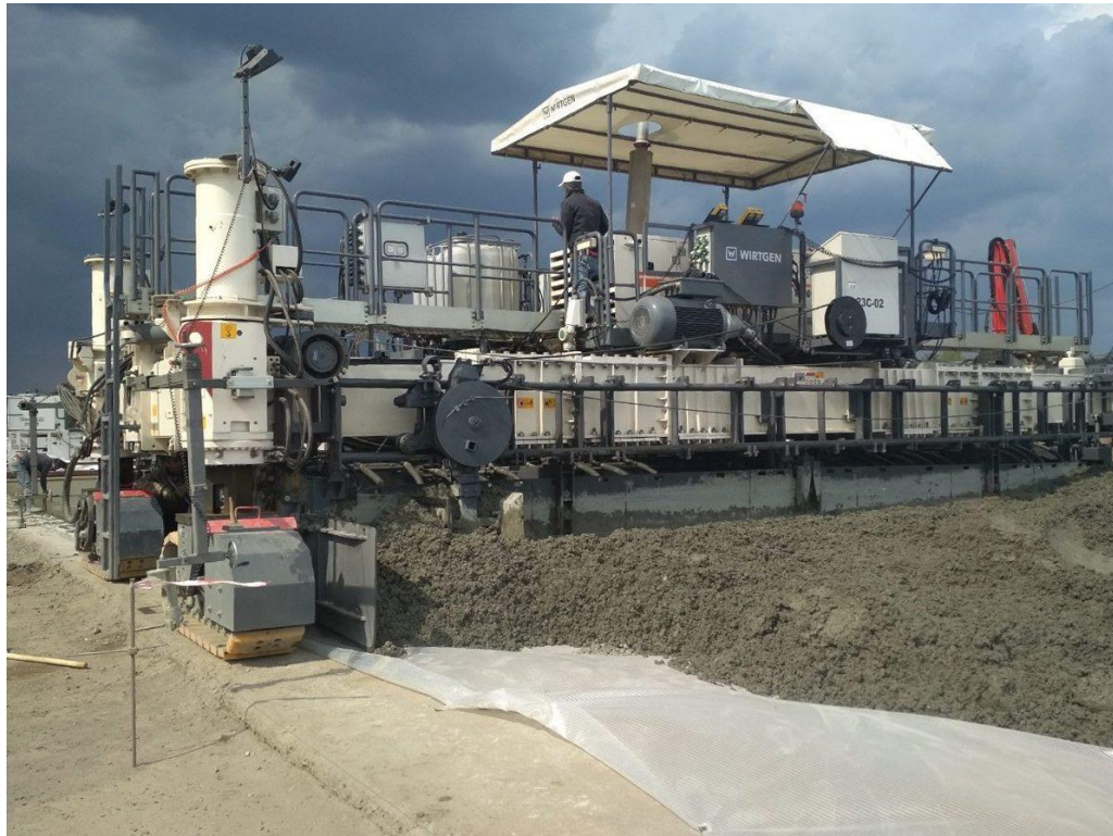
Рисунок 2.4 – Укладання цементобетону на ділянці будівництва автомобільної дороги Н-31 Дніпро – Решетилівка
