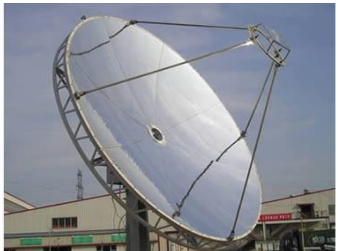
Рисунок 2.2 - Сонячна електростанція тарілкового типу
