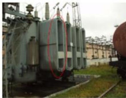
Рисунок 1.6 – Термограма і фотографія трансформатора (дефект системи охолодження)
