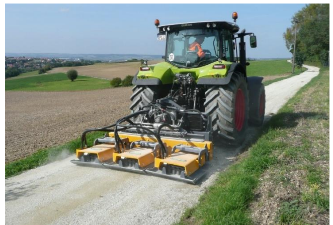
Рис. 1.2. Трактор з причіпною віброплитою на щебеному дорожньому покритті
