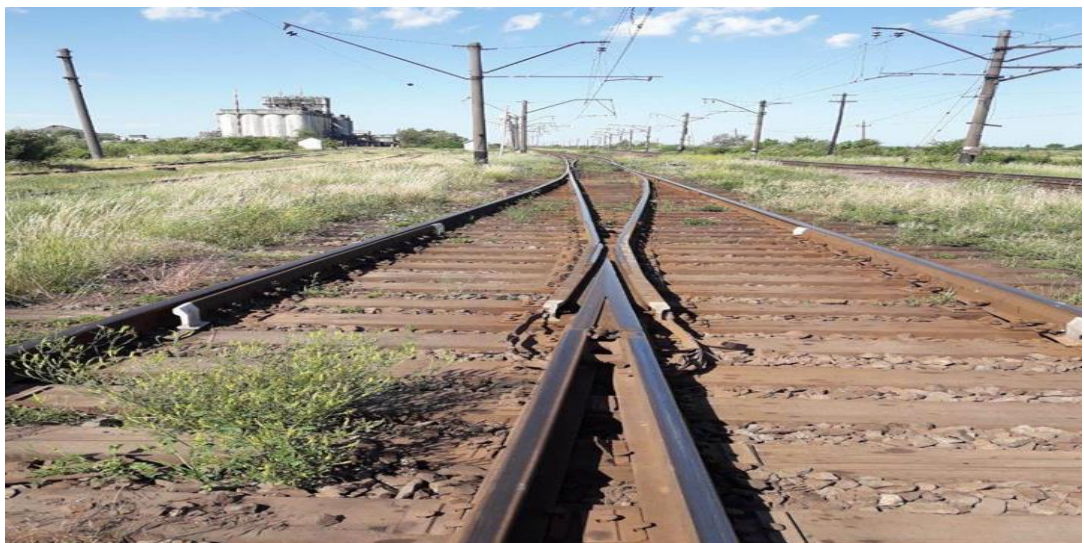
Рисунок 1.6 – З'їзд рухомого складу з суміщеної колії на окремо лежачу
