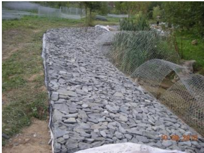
Рисунок - 2.2 Укріплення ґрунту Матрацами Рено
