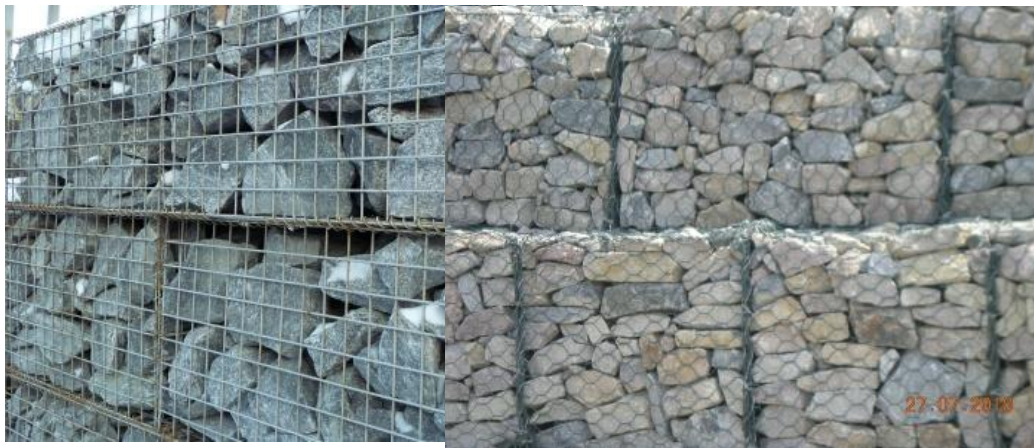
Рисунок - 2.1 Коробчасті габіони
