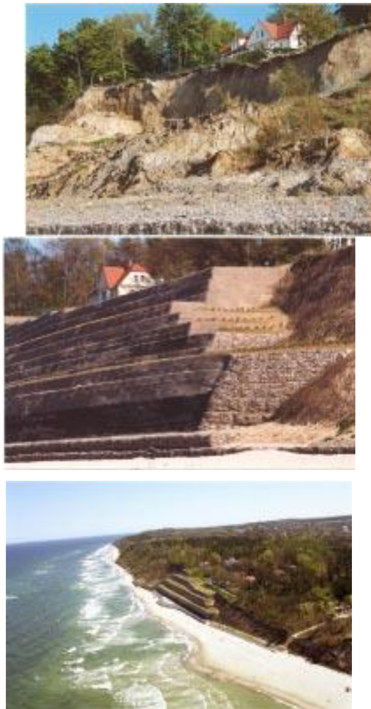
Рисунок - 2.4 Приклад укріплення берегів системою Террамеш.
