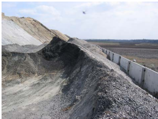
Рис. 1. Відвали забрудненого баластного щебеню
